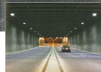
Intercambiador de l'Avenida de las Américas, Ecuador Fully lit with LEDs
