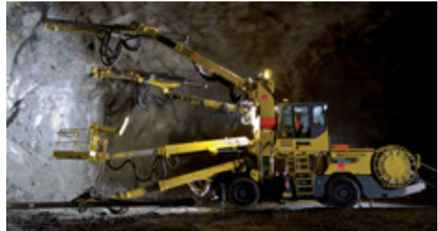
Atlas Copco boomer on the Norra länken bypass, Stockholm
