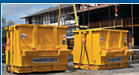
TUNNEL FRITZENS, Austria STRABAG, ZÜBLIN, HOCHTIEF muck container
