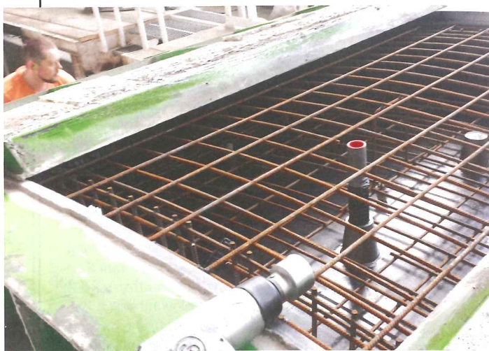
Above: Segment mould with rebar awaiting pour
