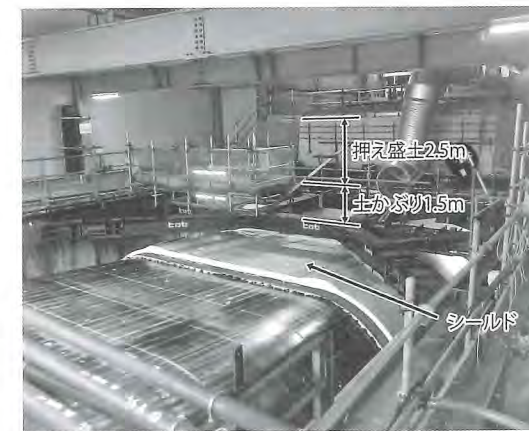
写真-2 シールド発進状況
