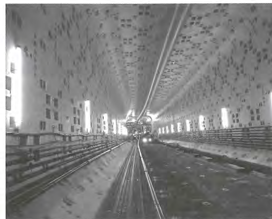
写真-5 坑内全景
