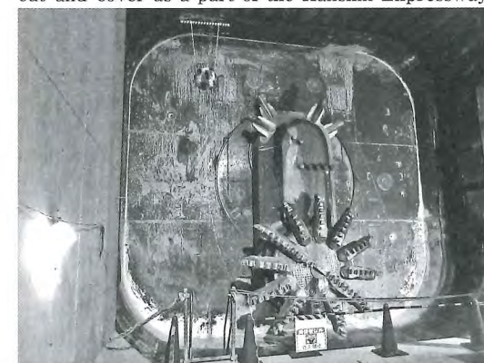
写真はシールド到達状況
