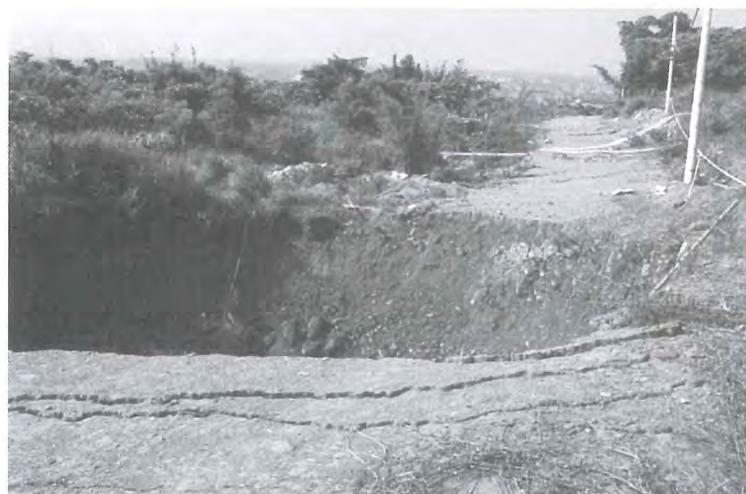
地表の陥没状況
