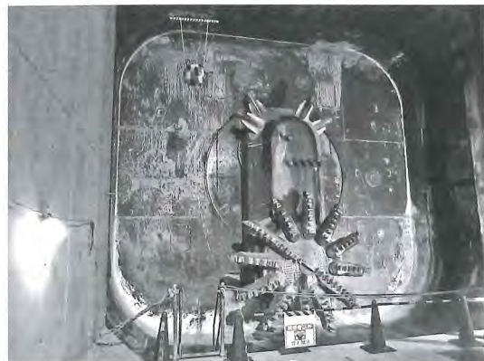
写真-6 シールド到達状況
