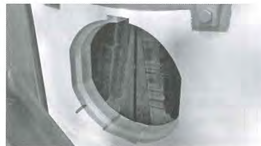
写真-6 スクリュー引抜き・ゲート閉鎖状況
