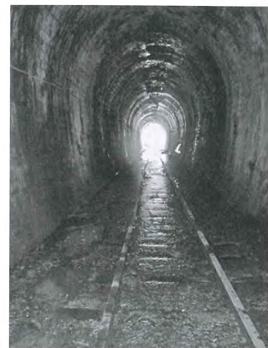
写真-6 戸下トンネル50m付近より入口方を臨む
