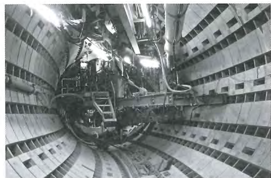
写真-10 急曲線(R=20m)掘進状況
