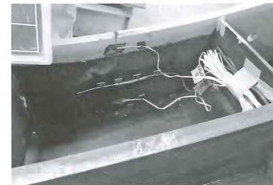
写真-8 ひずみゲージ設置状況
