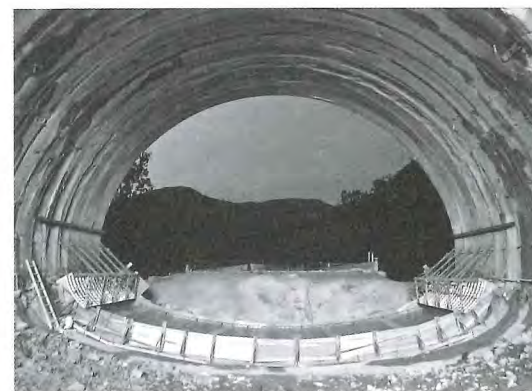
写真-7 最大断面 (DⅢ-L5 断面：掘削断面積226㎡)
