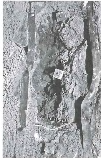
写真-3 支保工の背面の状況
