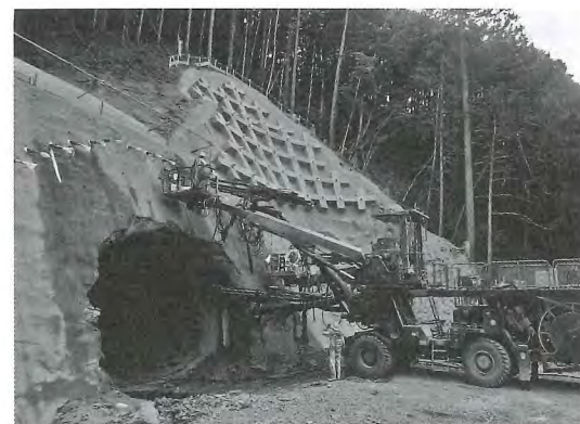
写真-4 終点側坑口長尺鋼管フォアバイリング施工状況 (先進導坑貫通後)
