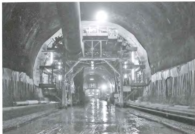
4 セットのセントル、鉄筋台車、インバート栈橋
