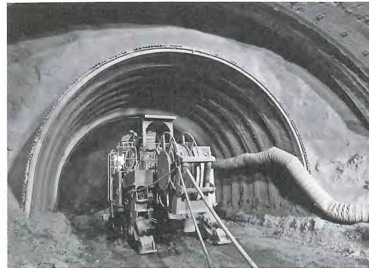
写真-3 先進導坑掘削状況 (DⅢ-L4 断面)
