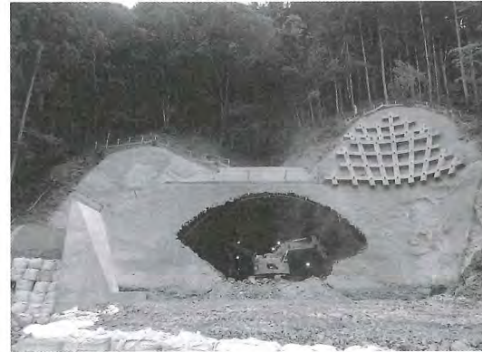
写真-6 上半掘削状況 (DⅢ-L5 断面)
