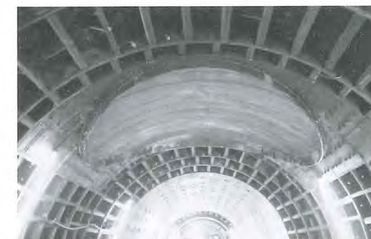
写真-3 シールド用のFFUセグメントの配置例
