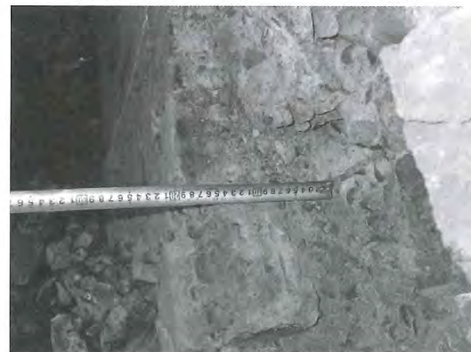
(b) 剝落箇所の拡大
