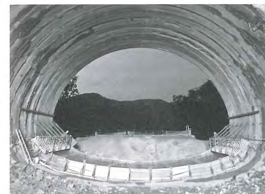
写真は最大断面(DⅢ-L5 断面: 掘削断面積226m 2 )
