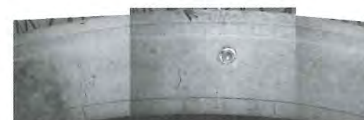
写真-7 単体曲げ試験後のGFRCセグメント
