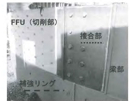
写真-4 立坑用のFFUセグメントの配置例
