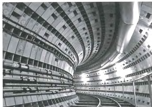
写真-11 坑内状況(R=20m)
