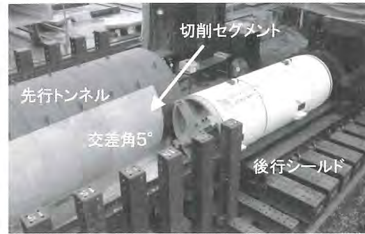
写真-11 先行トンネル切削実証試験の状況
