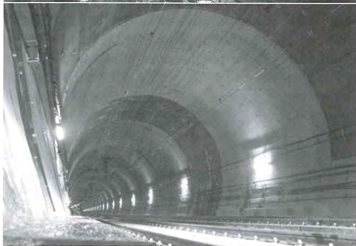
崩落箇所修復状況(①崩落状況→②修復状況→③修復完了)(土木学会「新潟県中越地震」報告会, 2005(平成17)年3月)
