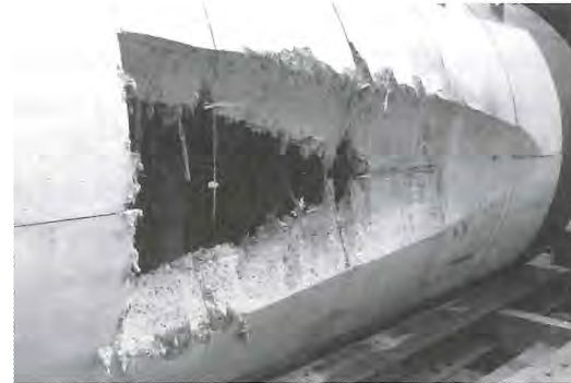
写真-12 先行トンネルの切削断面
