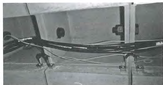
写真-9 π形ゲージ設置状況
