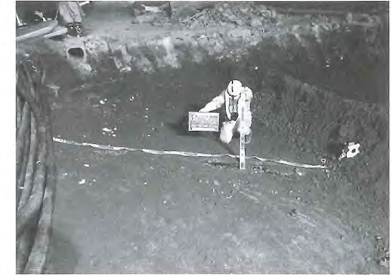
写真-5 インパートの状況(スパン12～13)
