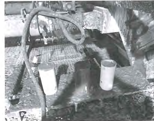
写真-1 妻部から排出されたモルタルの採取状況
