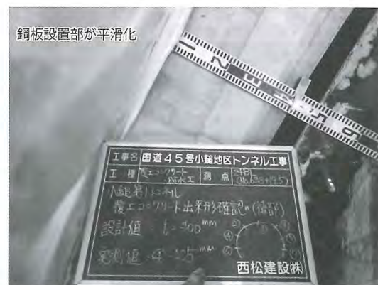
写真-9 妻部の仕上がり(対策箇所)
