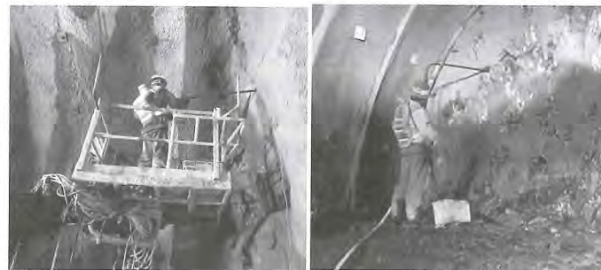
写真-8 遠隔装填による爆薬装填作業
