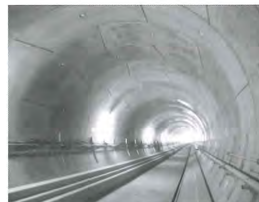
写真-3 施工完了後
