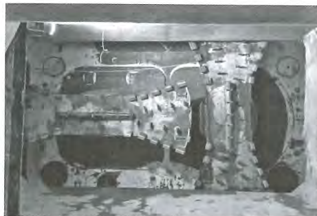
写真はシールド到達状況
