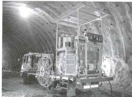
写真-1 爆薬の遠隔装填装置
