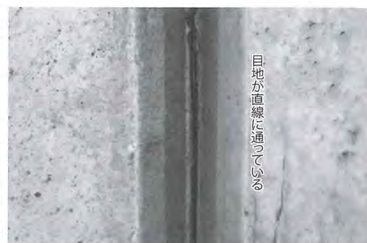
写真-7 施工目地近景(対策箇所)
