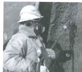
(RPE ロックボルト施工状況)
