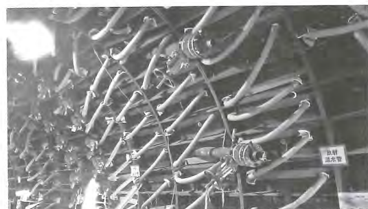
写真-1 貼付凍結管設置状況
