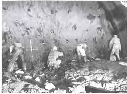
写真-7 人力による装填作業(従来の装填方法)
