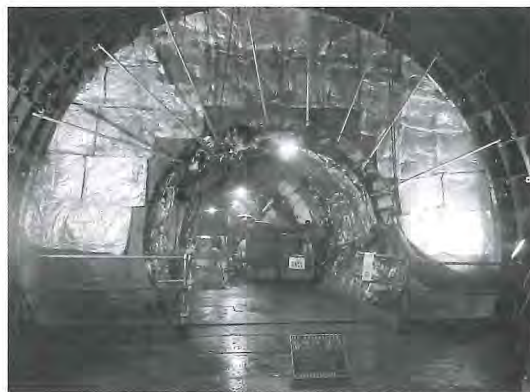
写真-3 凍土面防熱材設置状況
