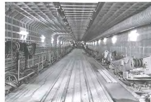
写真-2 坑内状況
