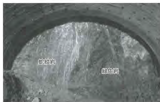
写真-2 蛇紋岩および緑色岩からなる切羽状況
