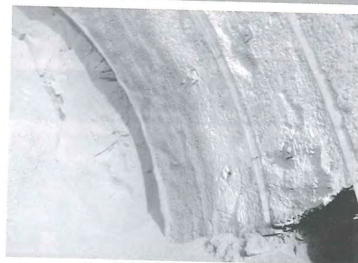
2. 吹付け完了 (凹凸あり)
