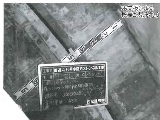
写真-8 妻部の仕上がり(未対策箇所)
