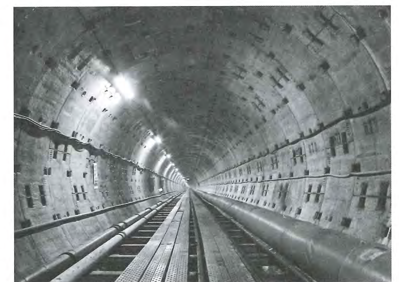
綾瀬川幹線トンネル坑内
