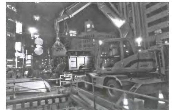
写真-4 汚泥搬出状況
