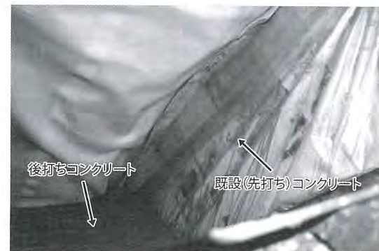
写真-2 ビニールシートによる対策の現場施工状況(打込み状況)
