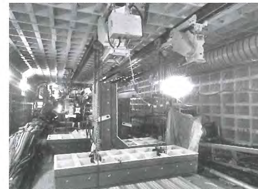
写真-3 セグメント搬送状況
