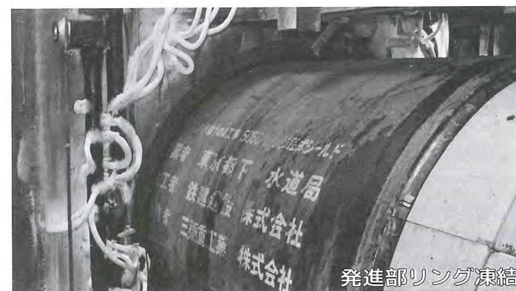
シールド発進部の状況
