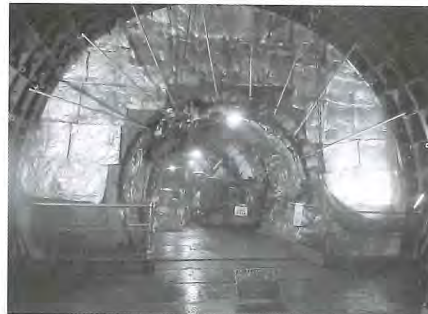
写真は凍土面防熱材設置状況
