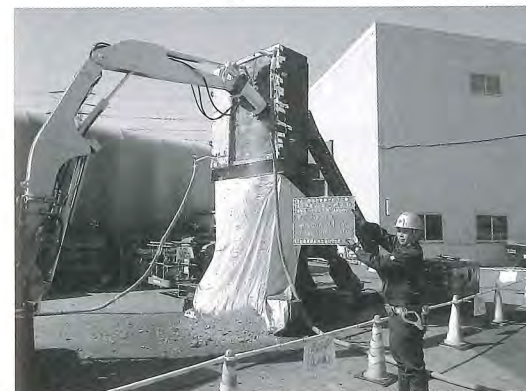
写真-2 凍土掘削実験状況
