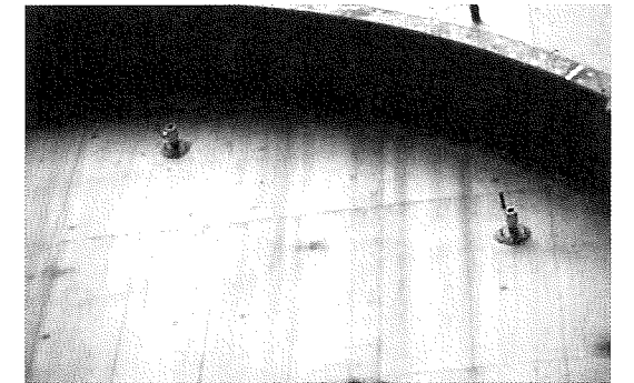
写真-2 止水性確認
