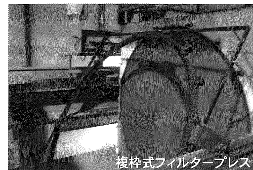
100.0 m³/Hr 濁水処理設備
