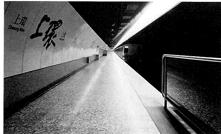
上環駅(トンネル駅、香港地下鉄402工区)
