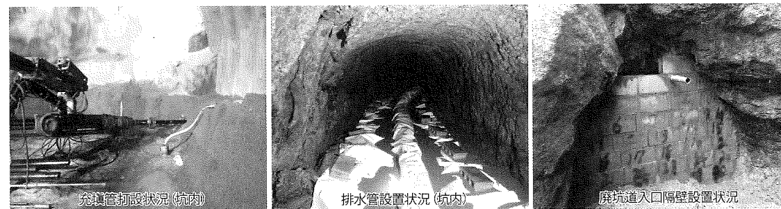
写真-11 対策工D充填状況
