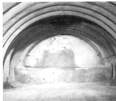
写真-8 二重支保工閉合状況全景
