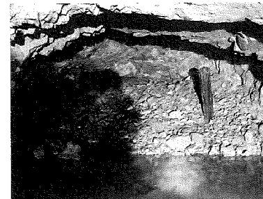
写真-5 対策工A側から見た対策工B内部の状況(充填前)
