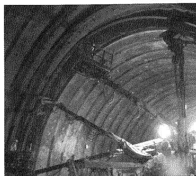
写真-7 二重支保工施工状況
