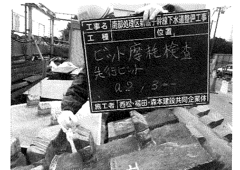
写真-2 ビット摩耗検査(3mm)
