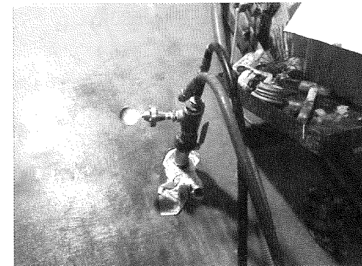
写真-4 坑内薬液注入状況
