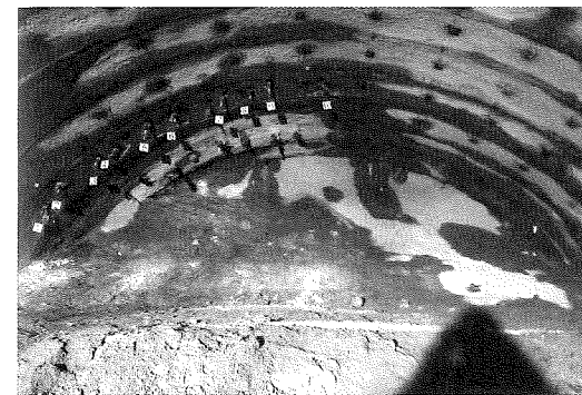
写真-2 空洞部充填完了
