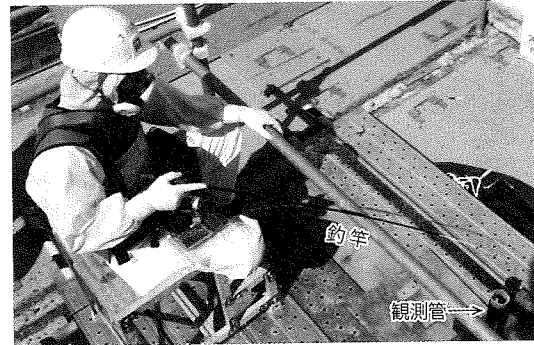
写真-8 打上り高さの測定状況
