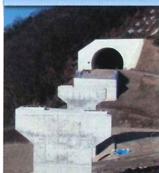
『CSA』でひび割れ抑制
