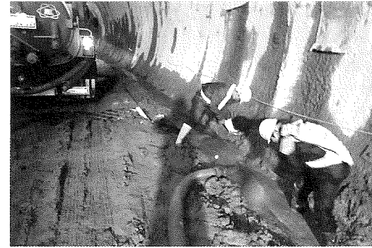
写真-7 バキュームによるヘドロ吸引
