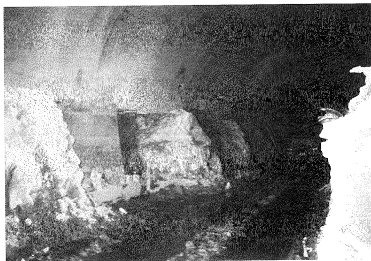
東北新幹線福島トンネルの脚付きコンクリート
