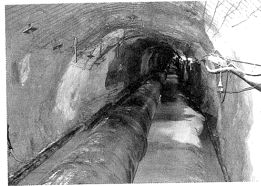
写真-1 導水用配管敷設状況(大川)
