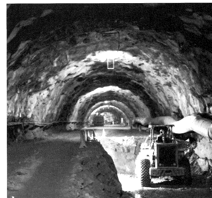
五日市トンネルAパターン
