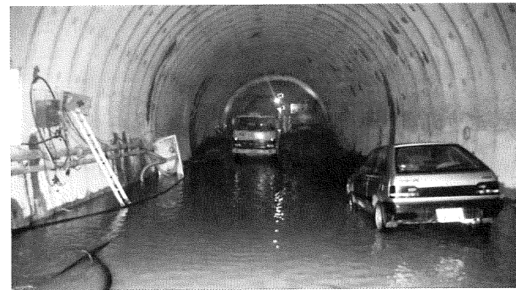
熊居トンネル湧水状況
