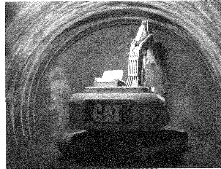
ADECO-RS的施工(D地山を全断面掘削)
