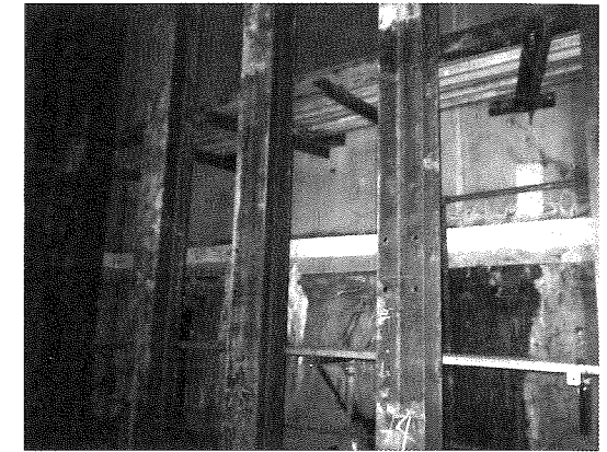
写真-6 支柱上部固定状況
