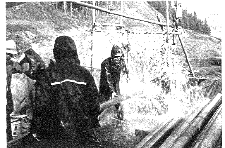
ボーリング状況
