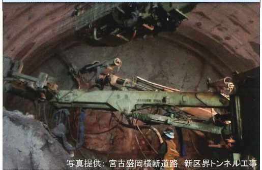
写真提供：宮古盛岡横断道路 新区界トンネル工事
