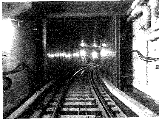
写真-2 通路線防護設置状況
