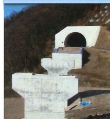
『CSA』でひび割れ抑制
