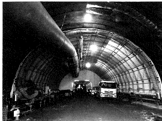
写真-4 実施工での加湿養生状況 9)
