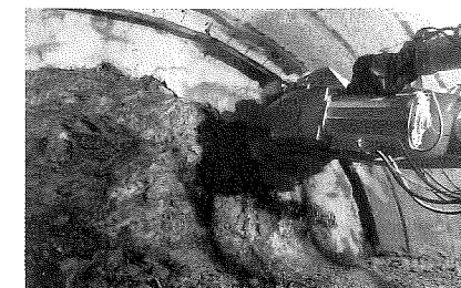
写真はTM-100による掘削
