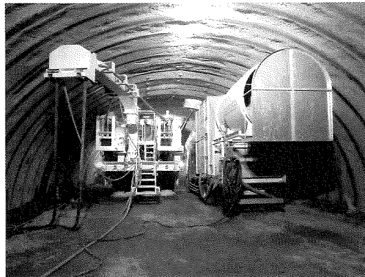
写真-6 掘削中の切羽(右側の機械が電気集塵機)
