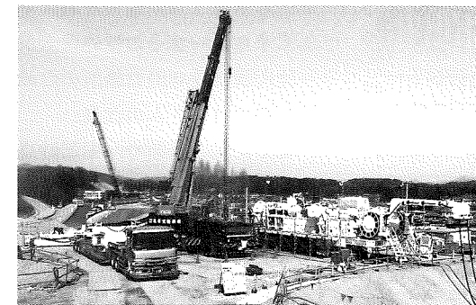
写真-4 TM-100組立て状況
