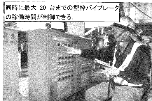
写真-1 型枠パイプ集中制御システム
