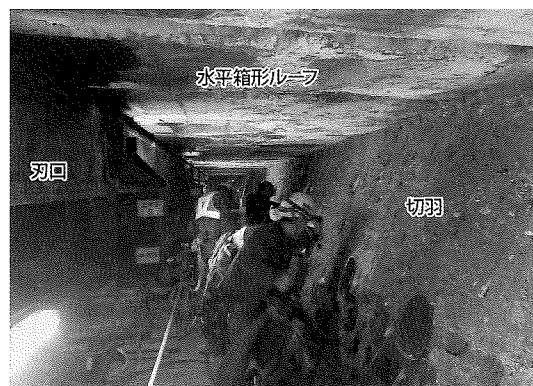
写真-3 切羽掘削状況
