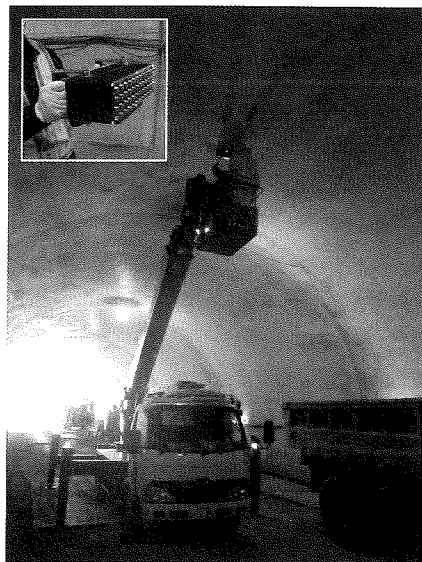
写真-12 超音波トモグラフィ法による覆工内部非破壊調査状況
