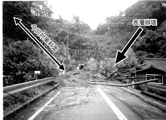
写真-12 海潟トンネル起点側の災害
