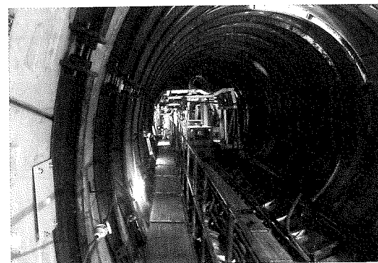
写真-7 補強リング設置状況
