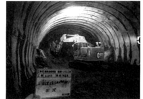
写真-5 2次破碎状況(割岩された岩盤を大型プレートでさらに破碎)
