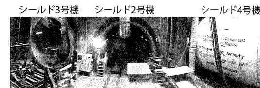
写真-6 3台同時掘進状況
