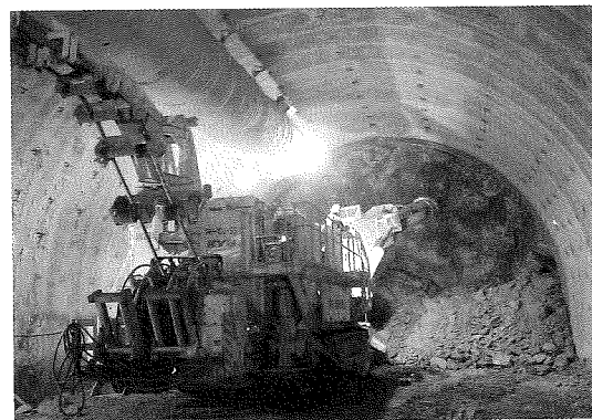
写真-1 八之尻トンネル全断面掘削状況
