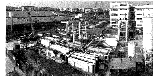
写真-5 発進立坑基地全景
