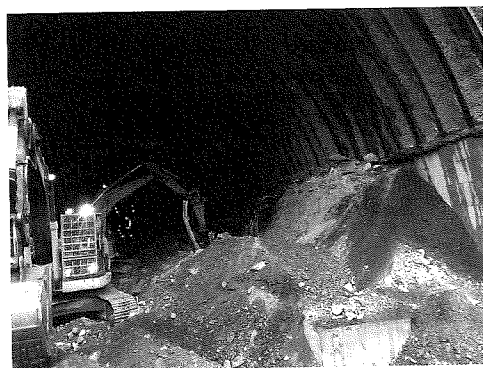
写真-2 掘削状況(中段・下段)
