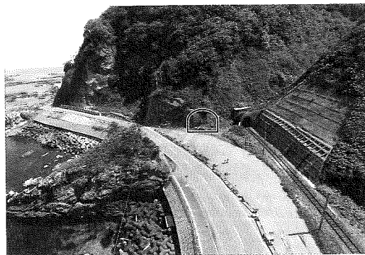
トンネル起点坑口部全景
