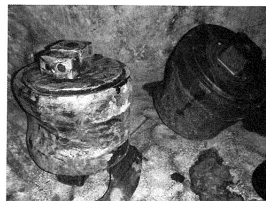
写真-5 リングが外れ損傷したディスクカッタ
