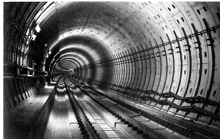
写真は地下鉄トンネル完成
