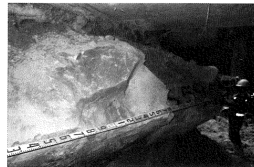
写真-10 駅掘削時の転石
