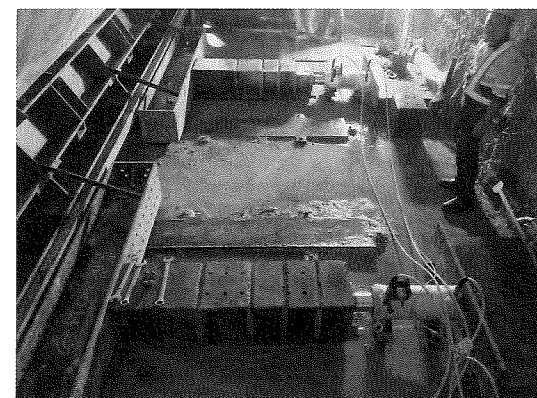
写真-7 ジャッキによるシールド横移動
