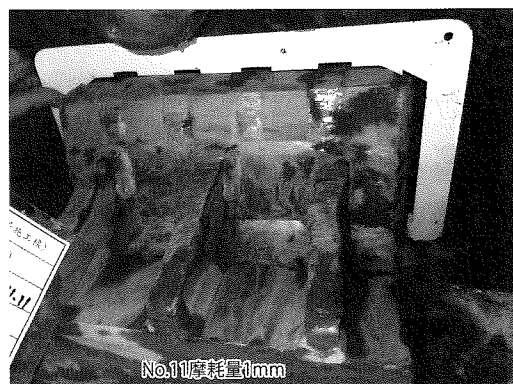
写真-2 ビット点検状況
