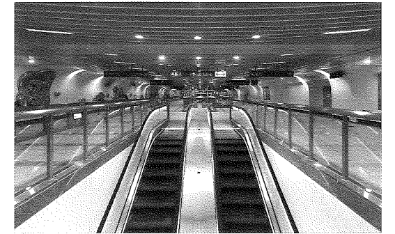
写真-3 地下鉄駅完成写真(象山駅)
