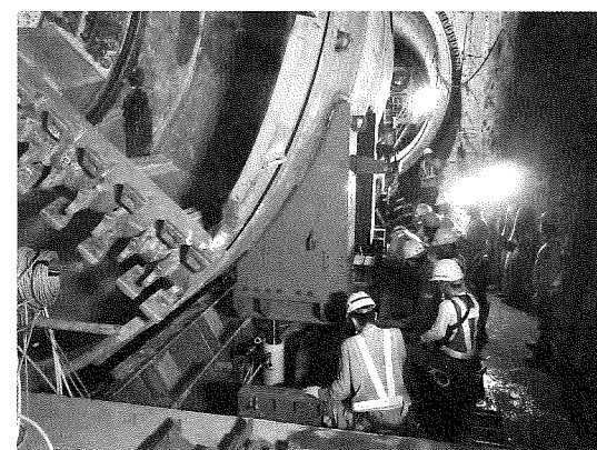
写真-8 シールドのジャッキアップ
