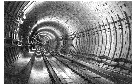
写真-2 地下鉄トンネル完成写真
