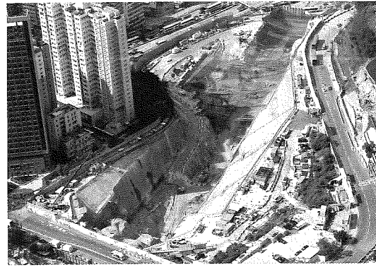
写真-6 ステージ2 発破防護(ルーフオーバー)
