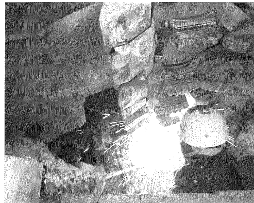
写真-3 地中でのビット交換
