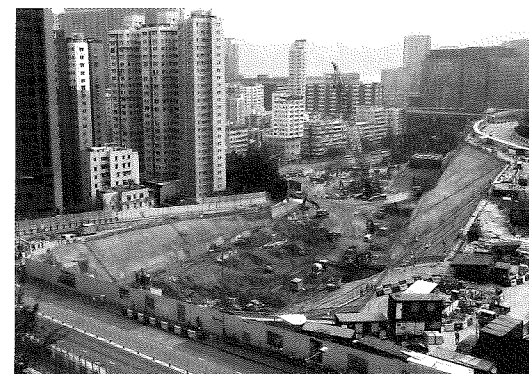
写真-4 急勾配法面による大規模オープン掘削
