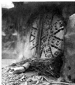
写真は岩盤到達状況
