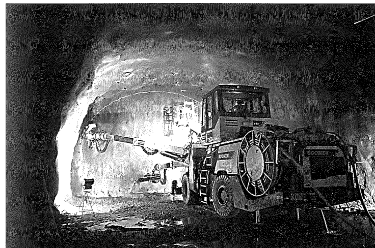
写真は長孔発破施工状況
