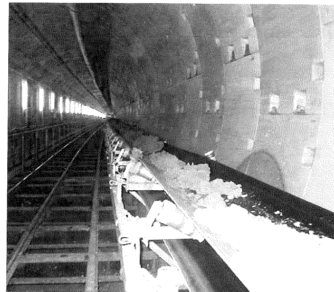
本山北工区にてシールド初採用の連続ベルコン(2000(平成12)年)
