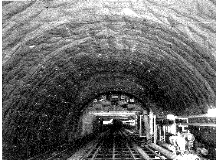
東京湾横断道路木更津南工区セグメントと二次覆工間に防水シート施工
