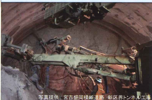
写真提供：宮古盛岡横断道路 新区界トンネル工事
