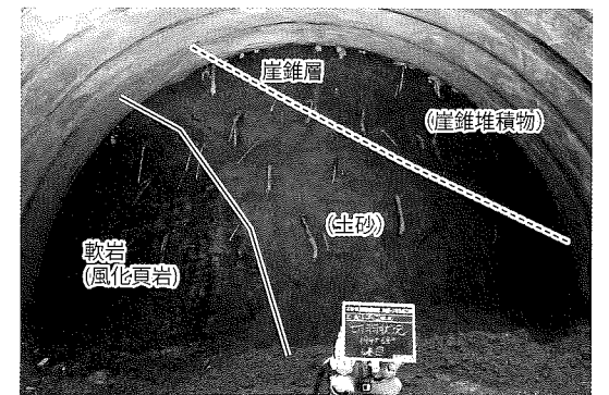
写真-1 坑口部切羽状況
