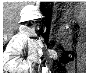
(RPE ロックボルト施工状況)
