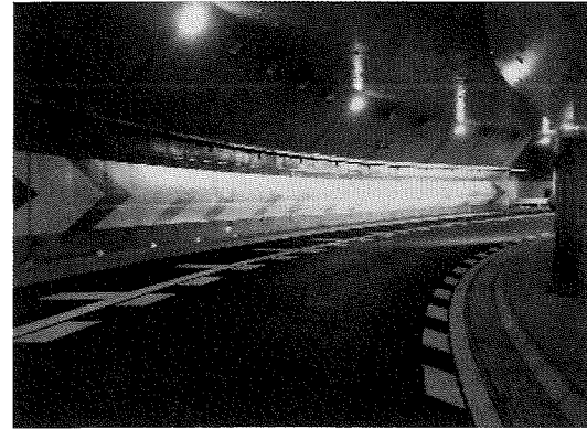
写真-13 完成トンネル内(一般部)
