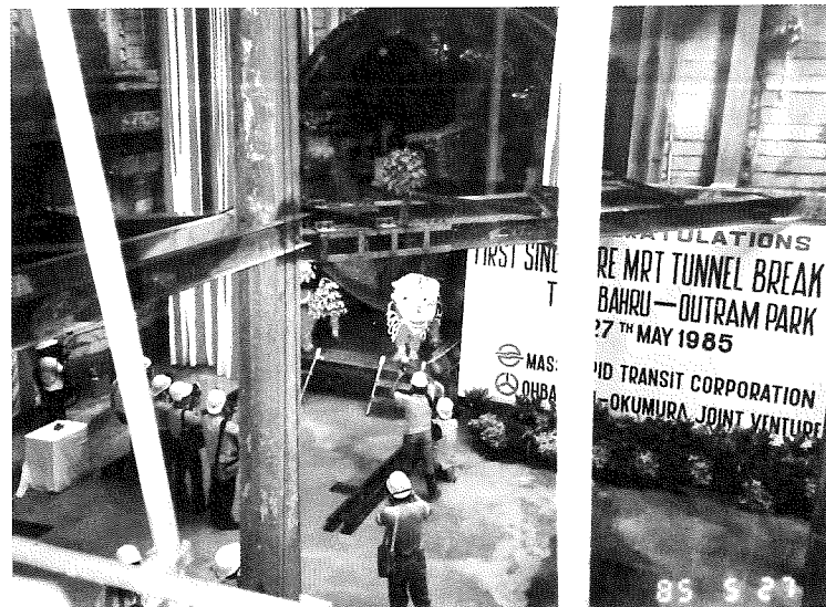
MRT109工区オートラムパーク駅に半メカシールド到達(1985(昭和60)年5月)
