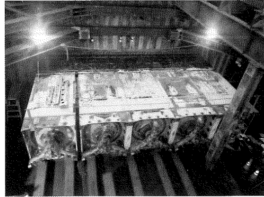
写真-4 U1掘進機到達状況
