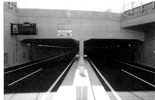
写真-5 国道17号トンネル完成
