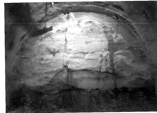
写真-1 硬岩出現切羽状況(48km660m)
