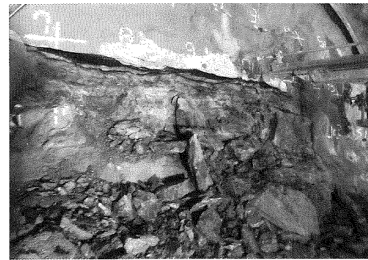
写真-3 上半切羽に出現した脆弱な泥岩(鏡ボルト施工)
