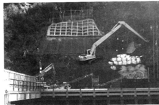
写真-2 法面対策施工状況
