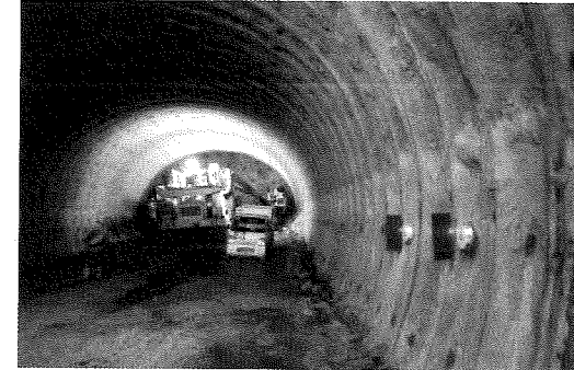
写真-8 受振ユニット設置
