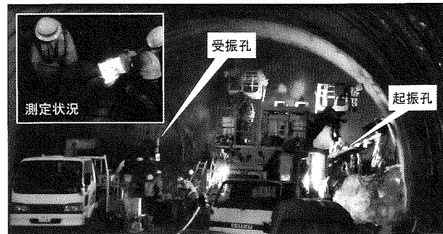
写真-4 現場実証試験状況
