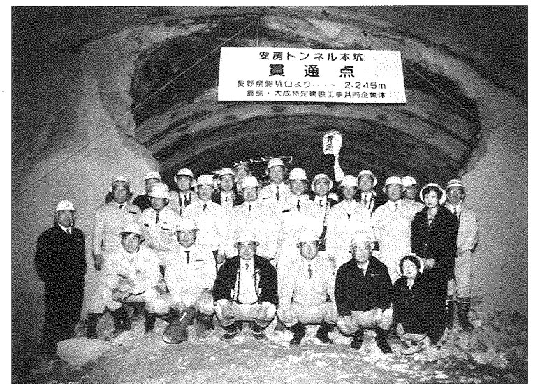
安房トンネル本坑貫通式、1995(平成7)年4月5日
