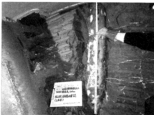
写真-3 松杭出現状況(切羽)
