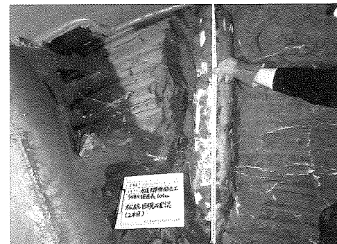
写真は切羽での松杭出現状況
