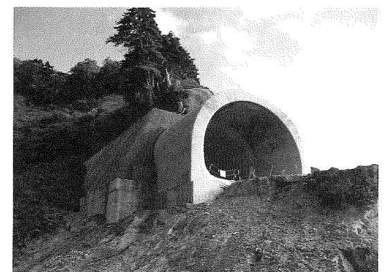
写真-4 トンネル完成状況
