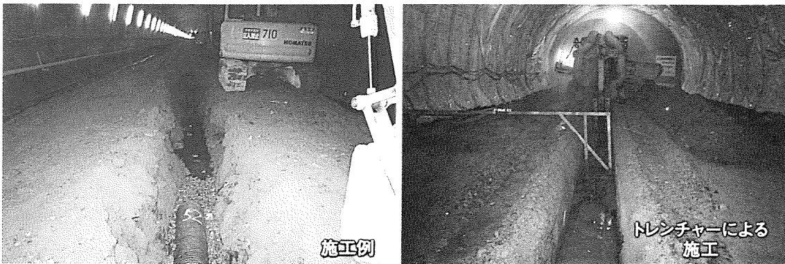
トンネル中央排水路掘削状況
