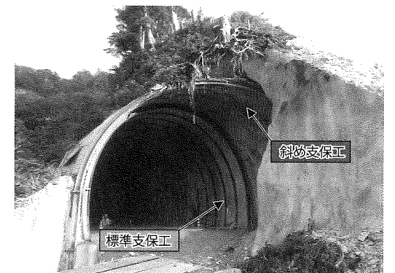
写真-3 越冬前貫通状況
