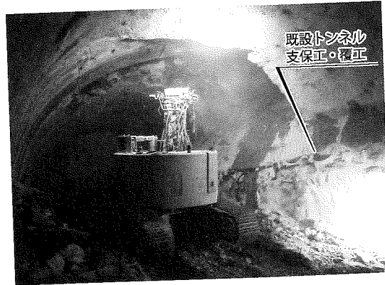
写真-1 分岐部掘削状況
