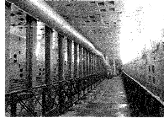
写真-7 仮設中柱の設置状況
