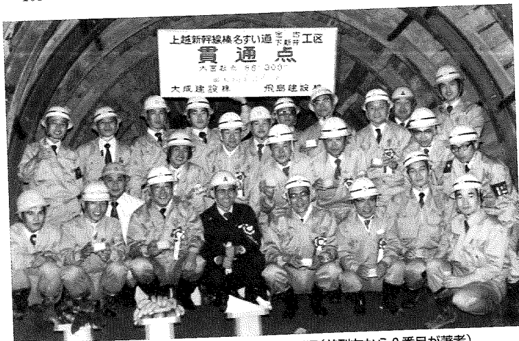
工事着手から5年7か月後に大宮方導坑貫通(前列左から2番目が著者)
