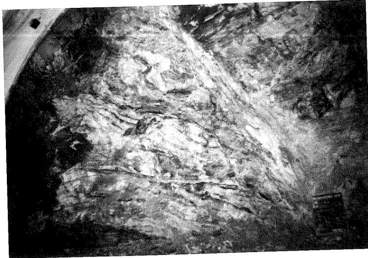
中央構造線断層破砕帯(本坑切羽)
