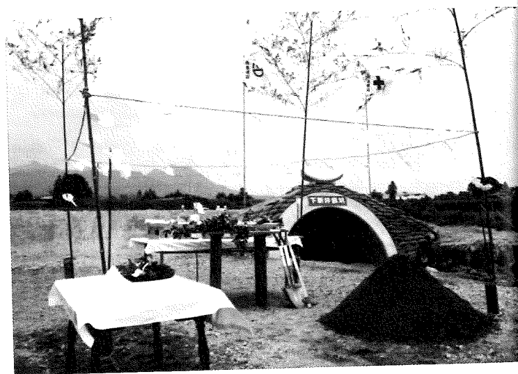
榛名トンネル下新井斜坑口(後方の山が榛名山)
