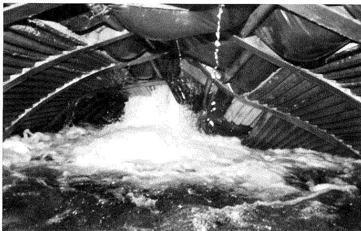
調査坑天端からの湧水状況(150t/min)
