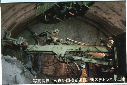
クリアショット吹付け状況（2ノズル吹付け）
