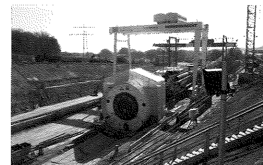
写真-3 TBM整備状況
