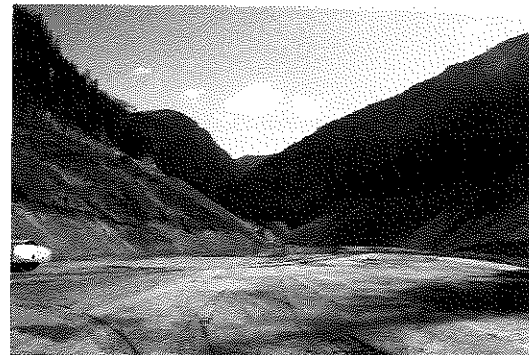
写真-7 土捨て場全景(上流側)
