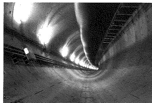
写真-2 坑内全景
