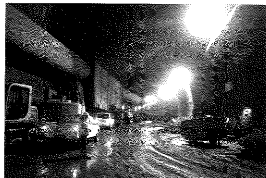
写真-8 アクセス斜坑全景
