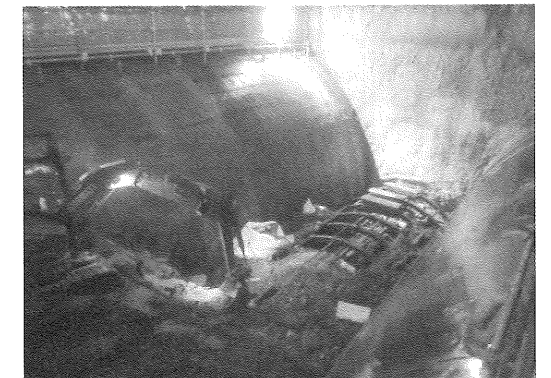
写真-12 トンネル間地盤掘削状況
