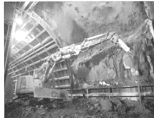
写真-4 0.45m 3 級掘削機械
