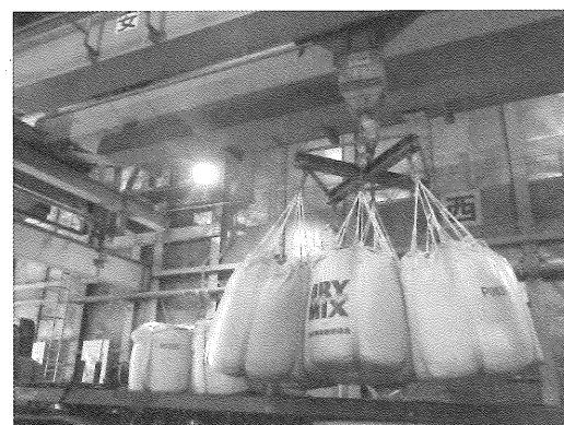
写真-5 ドライミックスコンクリート搬入
