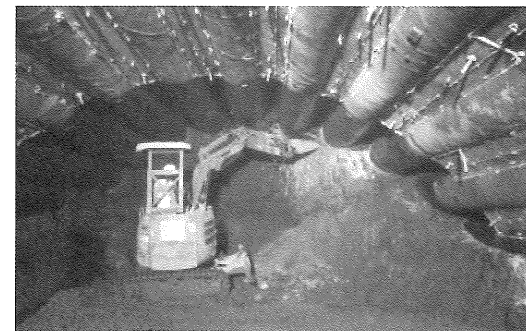
写真-10 パイプアーチ下の掘削状況(STEP-2)
