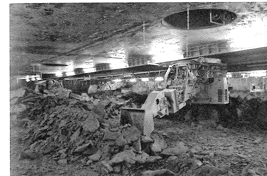
写真-10 沈下掘削状況
