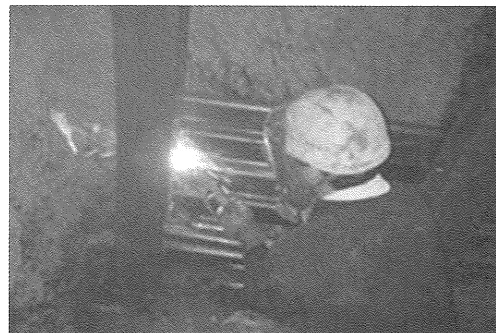
写真-3 鉄矢木溶接状況
