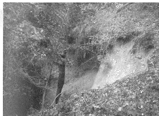
写真-1 地表面陥没状況
