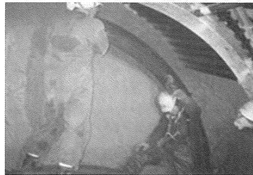
写真-2 支保工建込み状況
