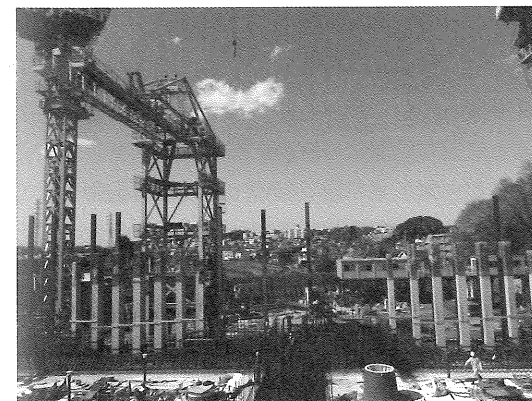
写真-1 シールド発進仮壁部 (SEW工法)
