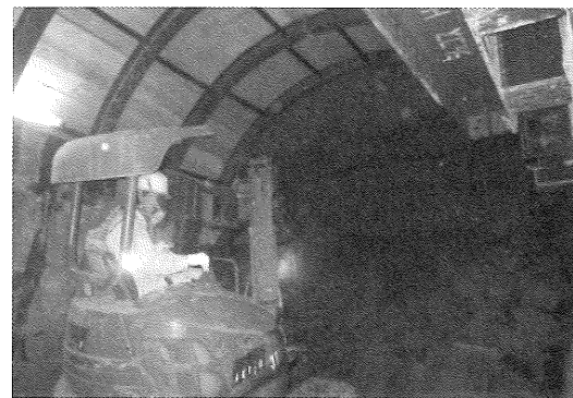
写真-13 導坑上半掘削状況
