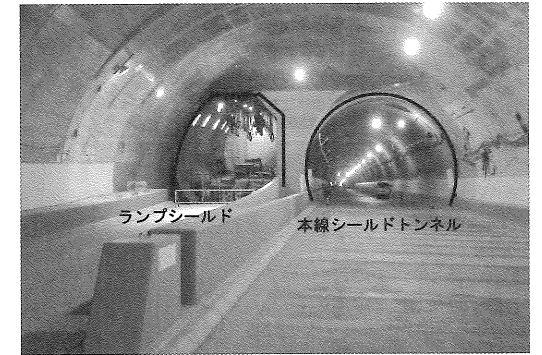
写真-8 分合流部施工完了
