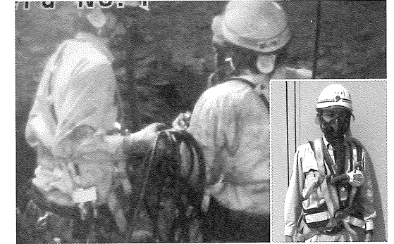
写真-11 ヘリウム混合ガスを吸引しながらの函内作業
