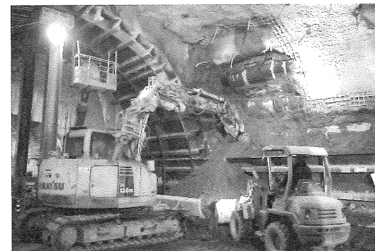
写真-7 掘削状況(8m幅)
