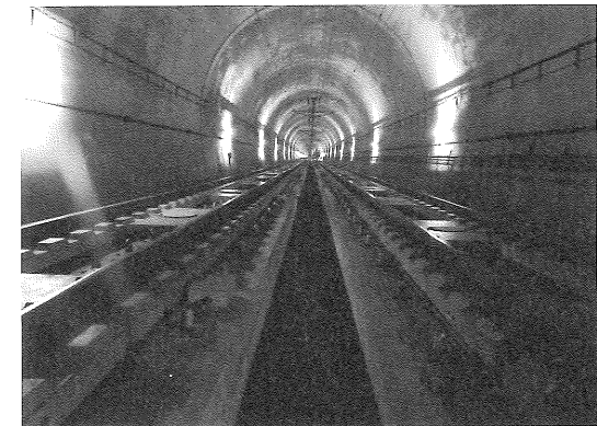
写真-1 施工後の状況(遠景)
