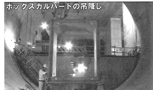
写真-1 吊降し状況
