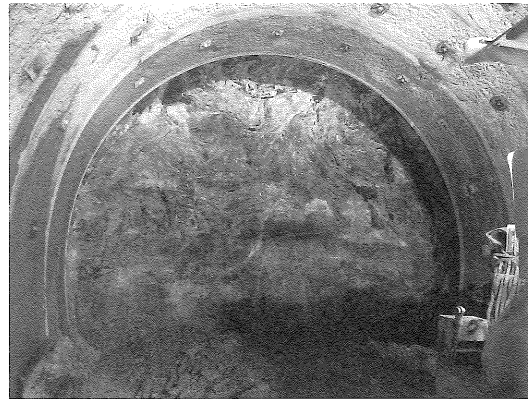
写真-2 切羽全景 (F21断層, No.41 + 39.3, 切羽評価点12.5)
