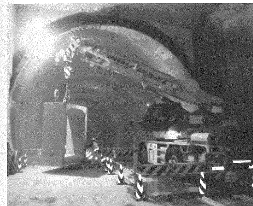
写真-3 立坑内の状況
