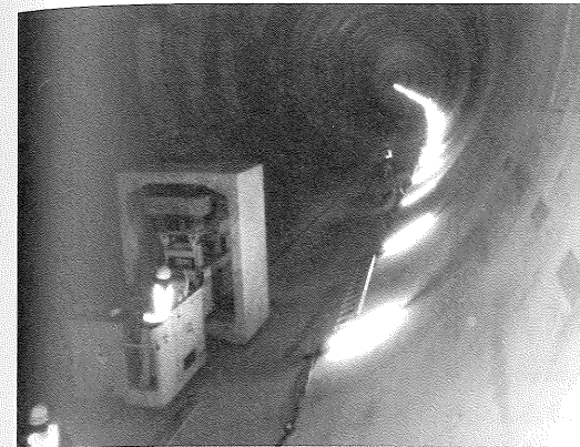
写真-2 ボックスカルバートの搬送状況
