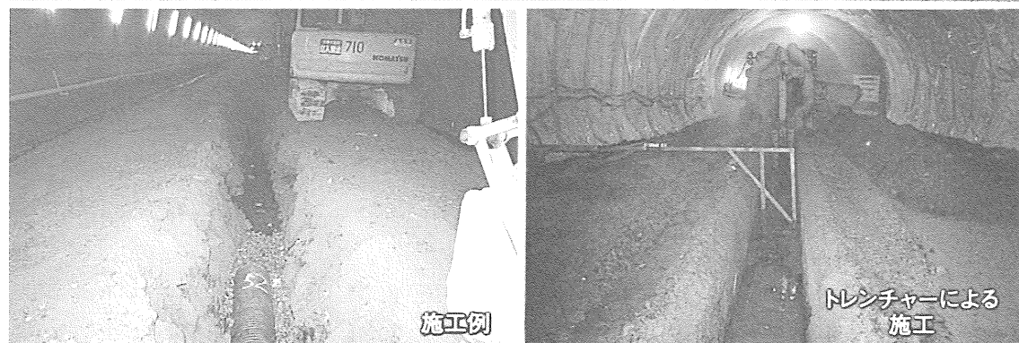
トンネル中央排水路掘削状況
