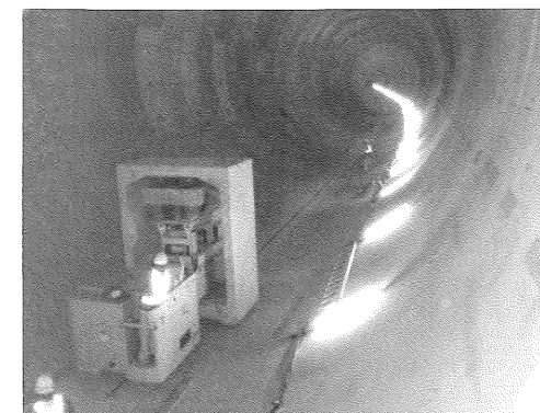
写真はボックスカルバートの搬送状況
