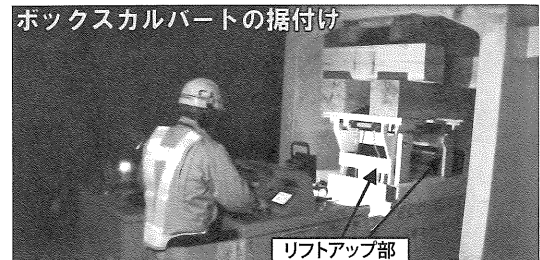
写真-6 微調整の様子
