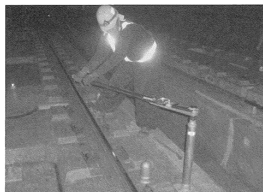
(4) ロックボルト頭部仮処理
