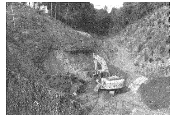
写真-4 表土剥ぎ取り状況
