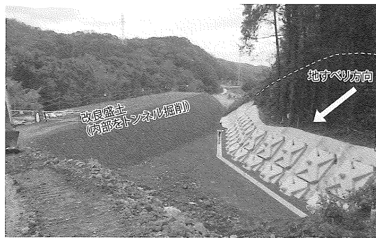
写真-7 グラウンドアンカー施工完了
