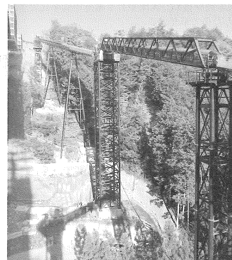
写真はベルトコンベヤの状況
