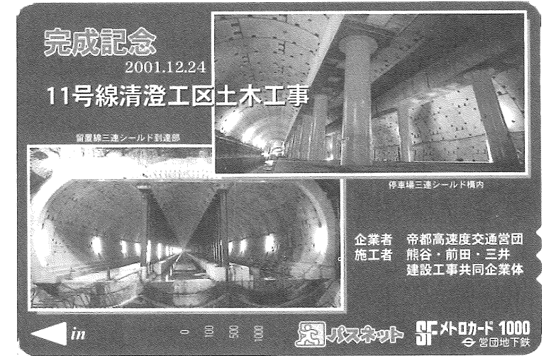
清澄駅完成写真：上段は駅部、下段は留置線部
