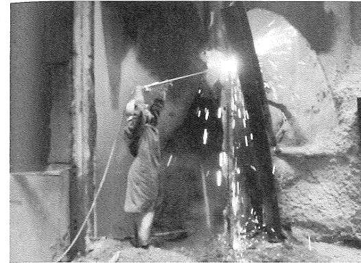
写真-3 鋼管矢板シャープランス切断
