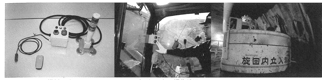
機材一式 オペレーター操作状況 重機取り付け状況
