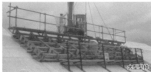
写真-11 透水性シートの鋼製型枠への適用例
