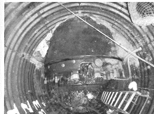
写真-4 シールド中間立坑到達状況
