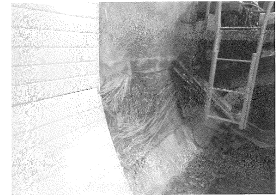
写真-8 ビニールシートによる乾燥防止対策
