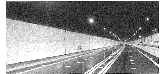
写真-8 補修工事完了状況
