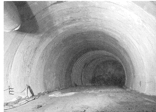
写真-7 吹付け仕上げ面
