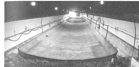
写真はインバート完成状況
