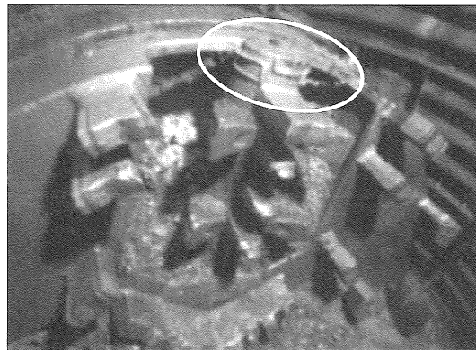
写真-6 二重ビット・NOMSTビット脱落
