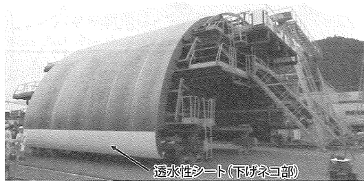
写真-4 透水性シートを装着したセントル
