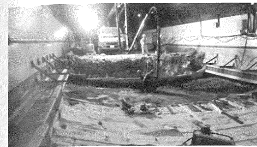
写真-5 インバートコンクリート打設状況
