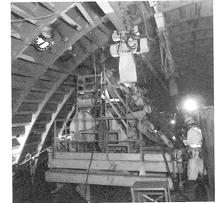
写真-6 細径曲線ボーリング施工状況
