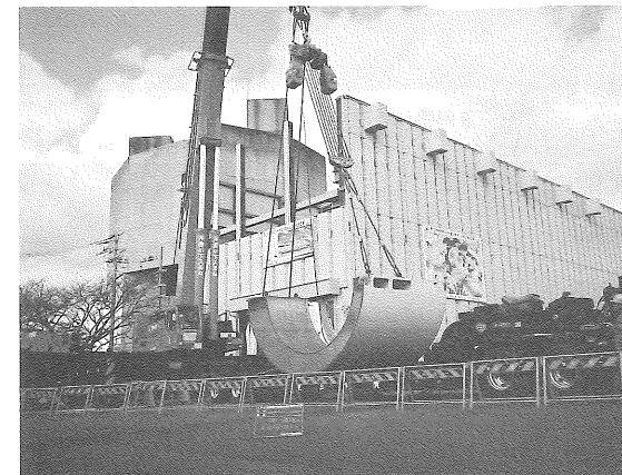
2号機外筒搬入
