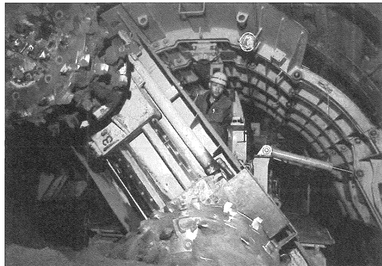
鍋沢・薬師トンネル導坑貫通
