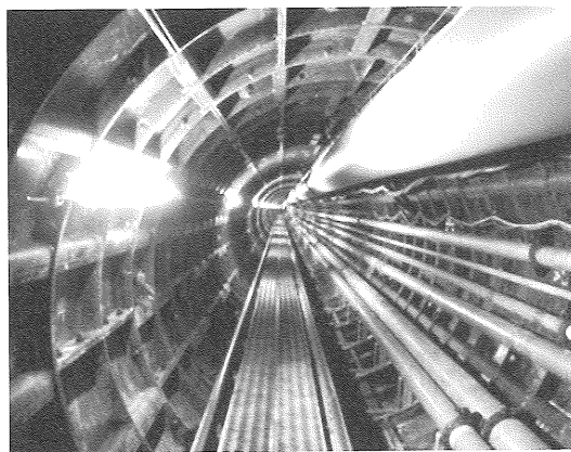
写真はシールド坑内全景
