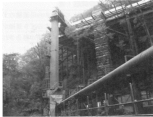
写真-1 堅シュート全景
