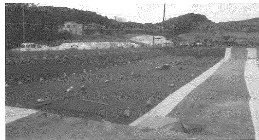
写真-5 遮水シート敷設状況
