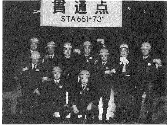
泊トンネル貫通
