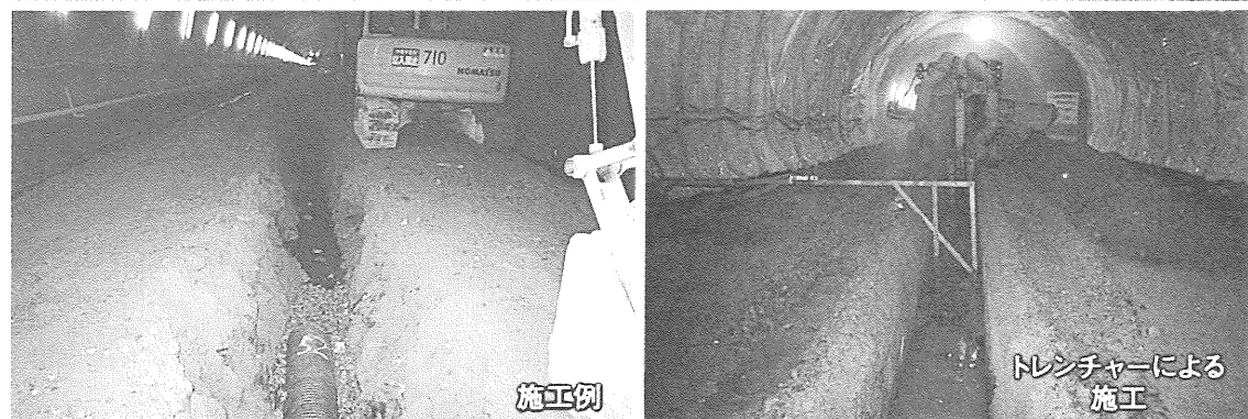
トンネル中央排水路掘削状況
