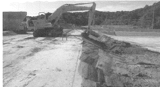
写真-4 ベントナイト混合土斜面部の施工
