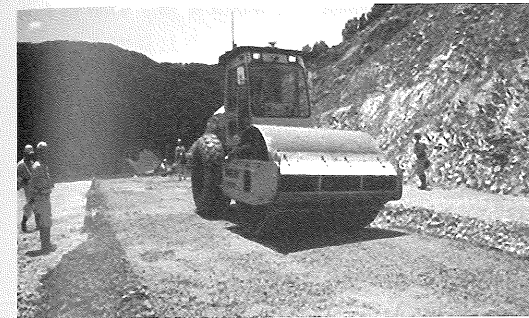
写真-6 セメント混合土転圧状況
