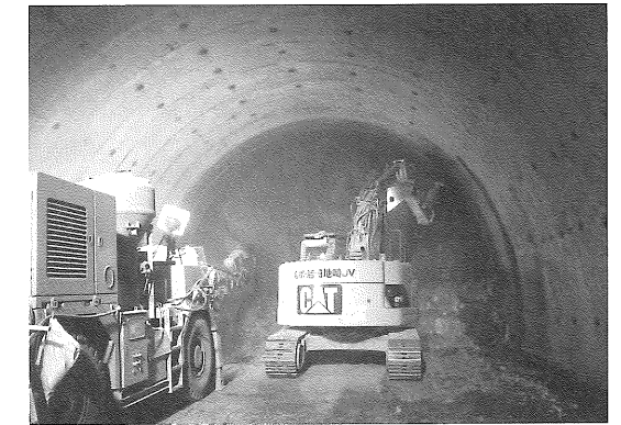
写真-7 吹付けと支保工清掃の並行作業
