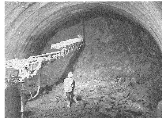
写真-5 切羽の早期安定
