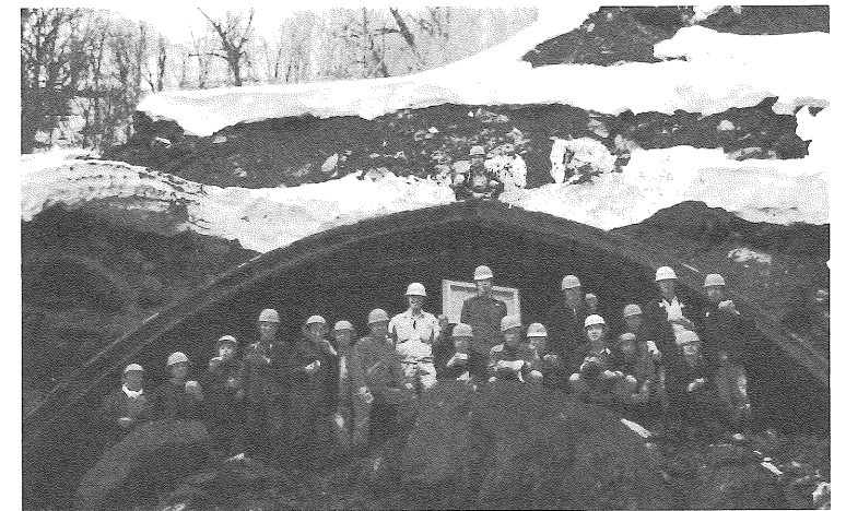
楢森トンネル貫通
