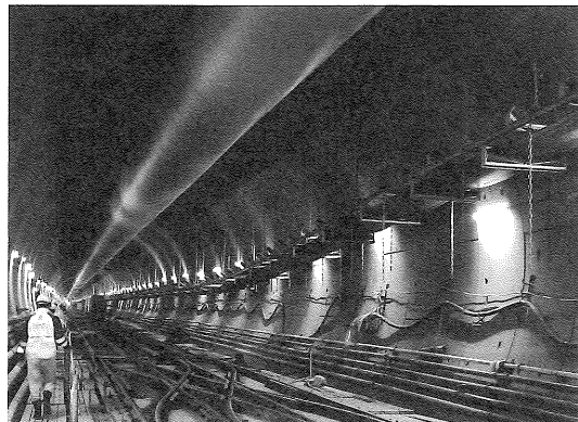
写真-6 水平コンベヤによる掘削土の運搬(坑内)
