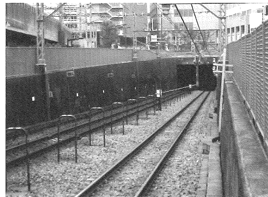
写真-5 トンネル坑口防水壁
