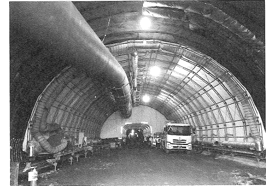
写真-2 実施工における湿潤養生の実施状況
