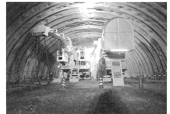
写真-10 掘削状況(掘削機と集塵機をセット)
