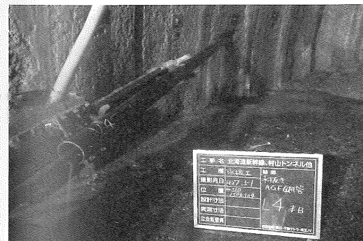
写真-3 ドリルジャンボによる削孔状況
