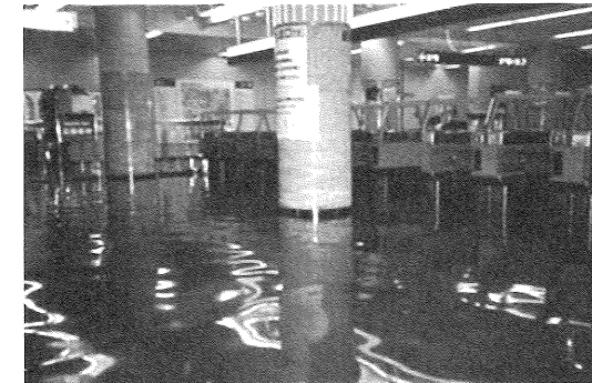
写真は溜池山王駅浸水事例
