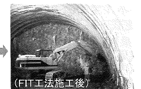
(FIT工法施工後)
