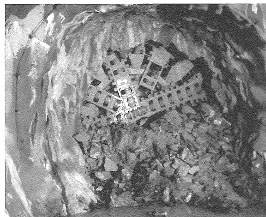
写真-4 SBシールド到達(岩盤開放到達)
