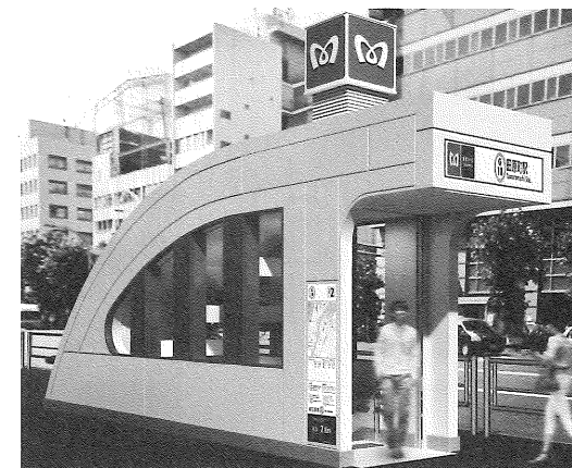
図-10 縦型折戸式防水扉上屋根格納時
