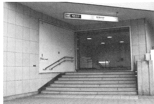
写真-4 駅出入口防水扉
