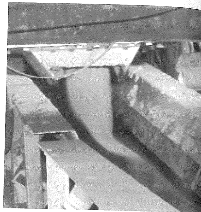
写真-2 排土状況
