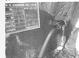
写真は水抜き状況(湧水量約490L/min)
