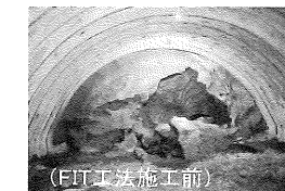
(FIT工法施工前)
