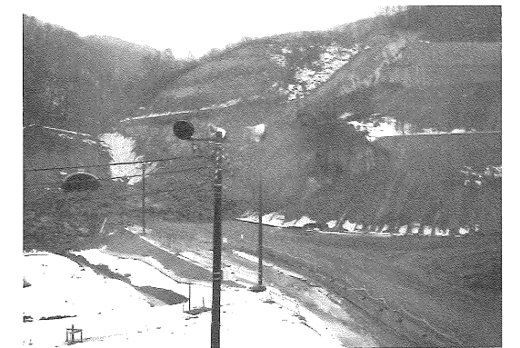
写真-5 終点側坑口部崩落状況
