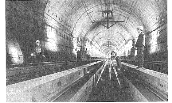
写真-2 青函トンネル本坑の内空断面測定
