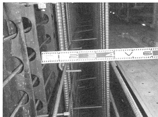
写真-6 孔あき鋼板ジベルと側壁鉄筋の状況
