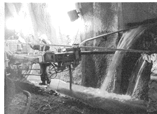
写真-4 ボーリング孔からの湧水状況
