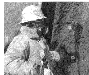
(RPE ロックボルト施工状況)
