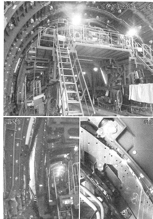
写真-2 フォームくぐり抜け状況(徳定トンネル: TAF 2号機)
