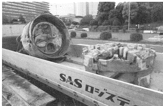
写真-9 マシン回収状況
