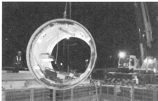
写真-8 マシン回収状況
