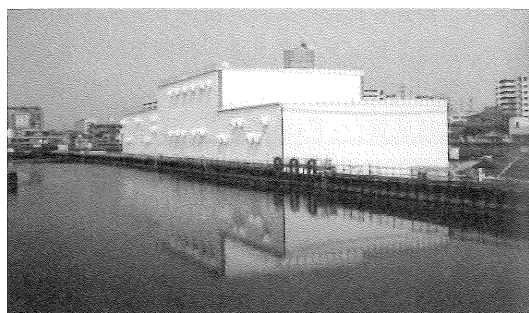
写真-2 脱水固化改良プラントの全景
