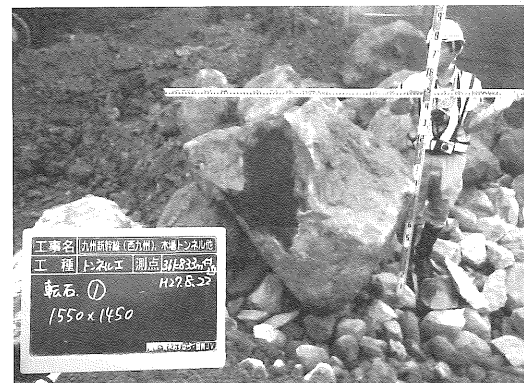
写真-3 巨礫出現状況(36km833m付近)
