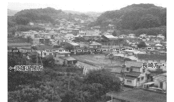
写真-1 木場トンネル直上の住宅密集地
