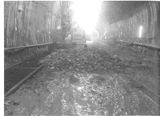
写真-6 栗石・ロードマットによる路盤泥濘化対策状況
