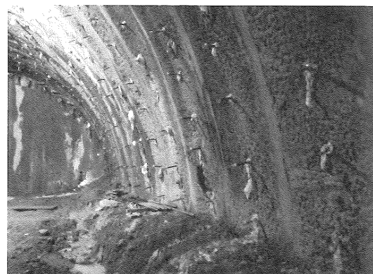
写真-2 注入式ロックボルト
