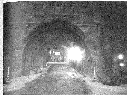
写真-3 段差のない避難連絡坑の活用
