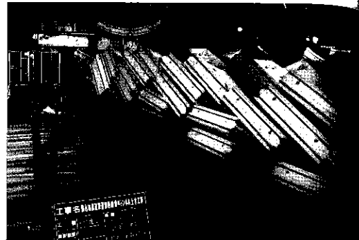
写真-10 セグメントの荷崩れ
