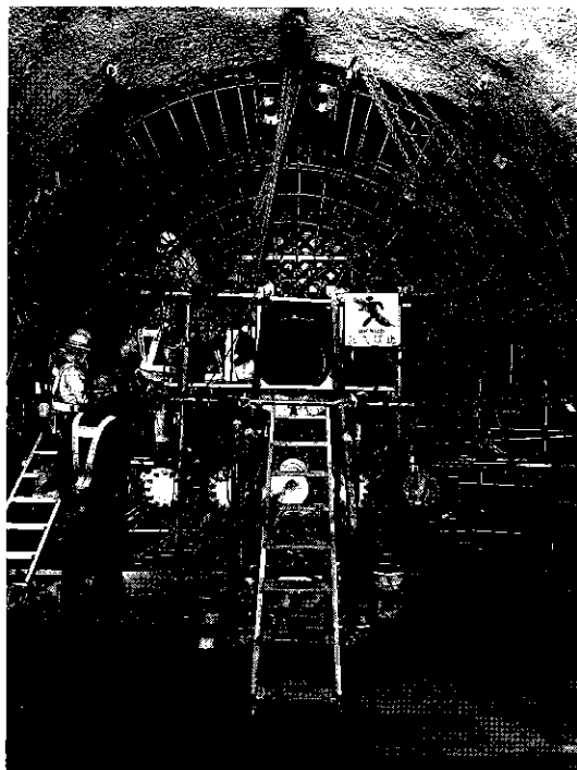
写真-1 止水壁設置状況 (2015(平成27)年2月撮影)
