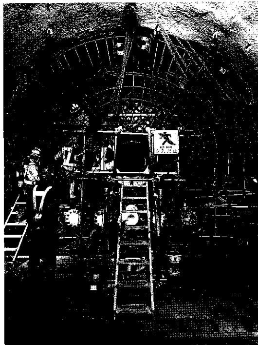
写真は止水壁設置状況(2015(平成27)年2月撮影)
