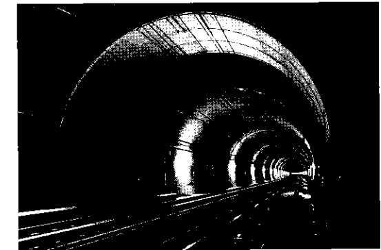
パネル系当て板工の完成状況
