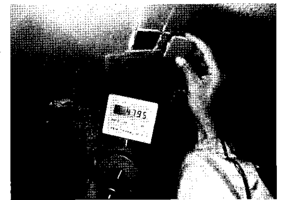
写真-5 吹付け塗装による剥落防止層の厚さ測定
