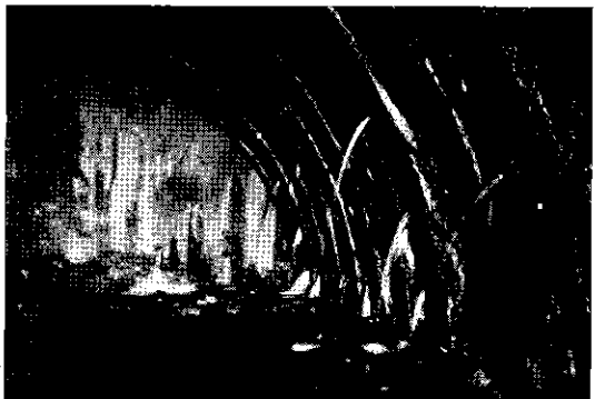
写真-2 トンネル掘進時の壁面湧水状況
