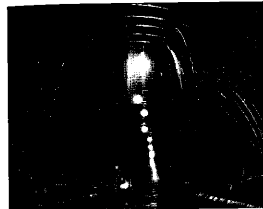
写真-4 天端からの湧水状況
