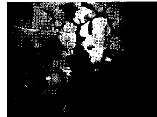
写真-10 吹付け工の変状(ひび割れと漏水)
