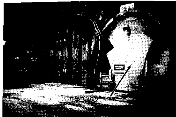
中壁コンクリート施工状況
