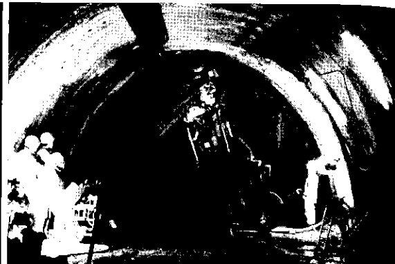
長尺先受け工法施工状況
