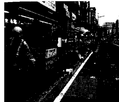
写真-2 現地状況②
