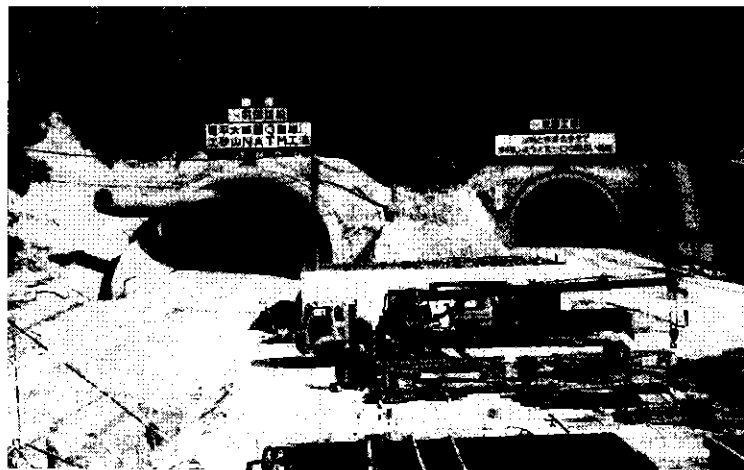
平井トンネル坑口(左)上り線、(右)下り線
