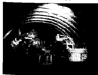
写真は上半掘削状況
