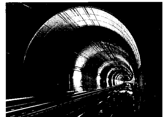
写真-4 完成したFRP内巻き工
