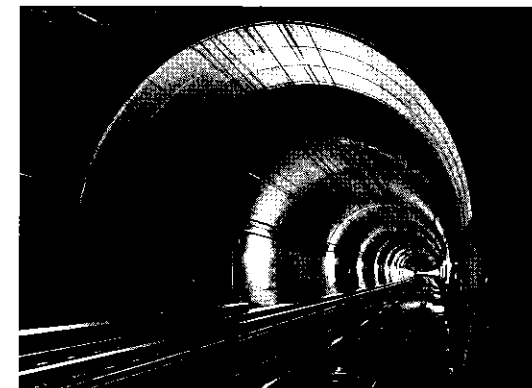
写真は完成したFRP内巻き工
