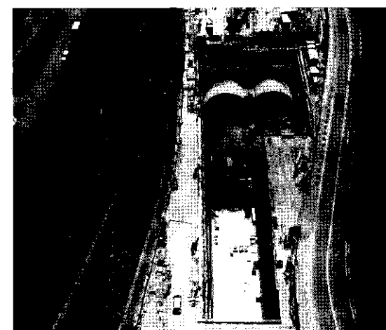
現場俯瞰写真
