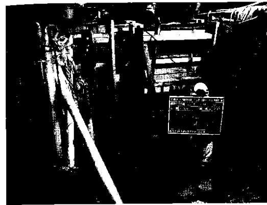
写真-5 仮堰設置状況
