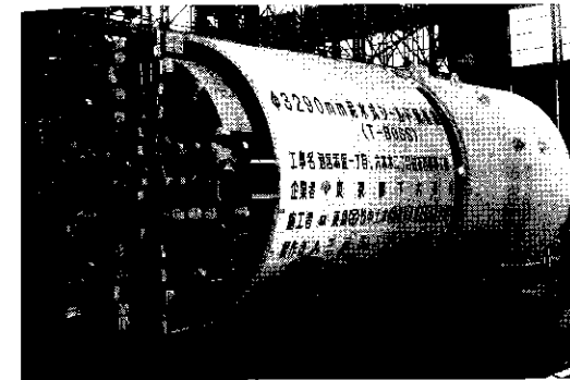
写真-1 W方式(通常掘進時)
