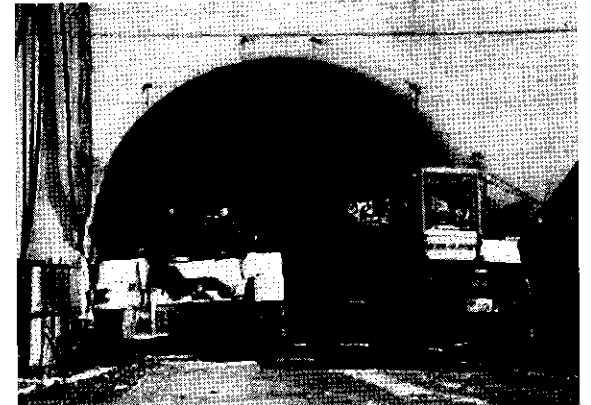
トンネル・コンテナ工法(キルナコンビ全景)
