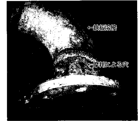
写真-6 排泥管摩耗による穴あき
