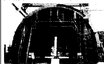
高流動コンクリート対応型 全断面ステンレスフォーム
