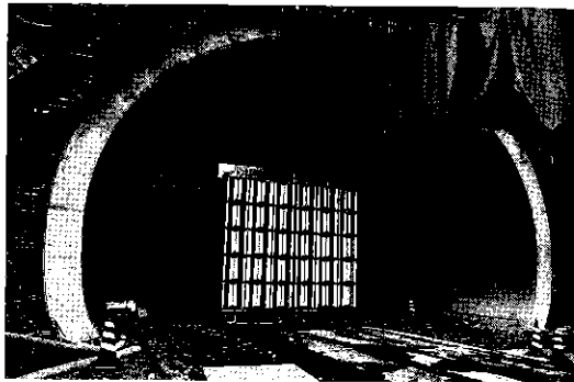
写真-8 消音システム設置状況
