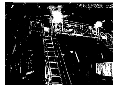
写真はくくり抜け状況
