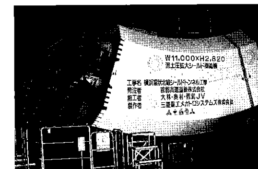
写真-1 拡大シールド仮組立て状況
