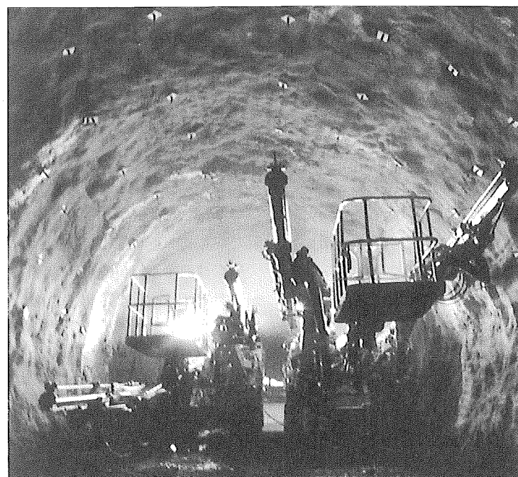
今市発電所導水路工事 坑内状況
