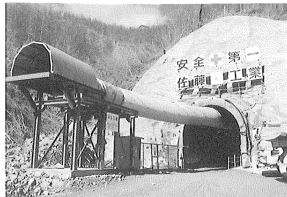
今市発電所導水路工事 坑口全景(1981春)
