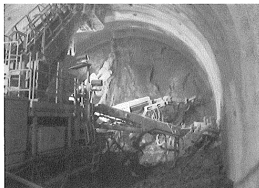
写真-4 2ノズル吹付け施工状況
