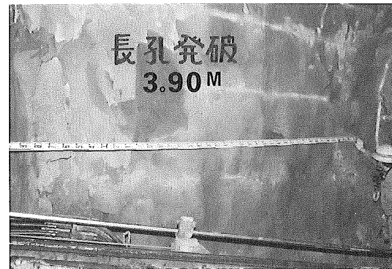
今市発電所導水路工事 3.9mの長孔発破
