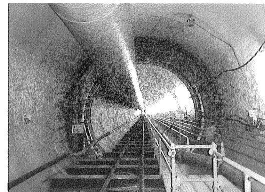
写真は子機発進状況(親子分離工)
