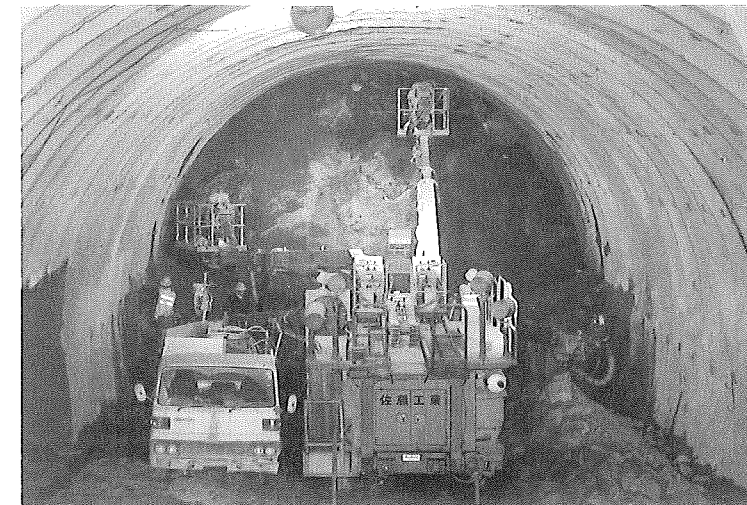
杵島トンネル工事 上半ロックボルト打設と下半装薬孔せん孔の並行作業
