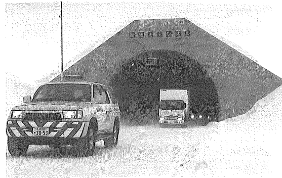
開通した新送毛トンネル(写真提供:札幌開発建設部)
