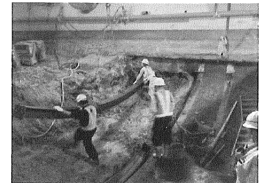
写真-10 鋼製支保工設置状況
