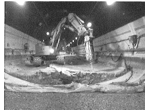
写真-9 インバート切削状況
