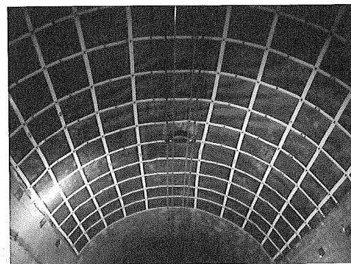
写真-2 樹脂ネットによる対策
