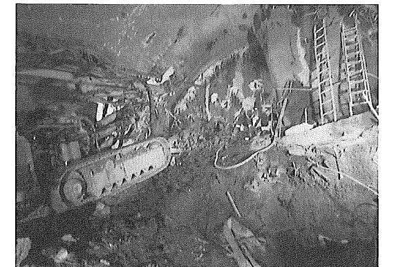
写真-9 北エントランストンネル斜坑掘削状況
