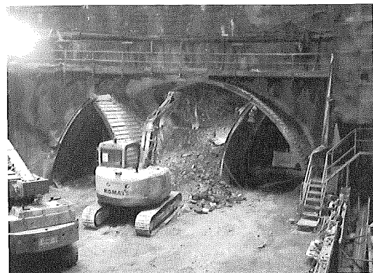
写真-4 西換気兼接続通路トンネル施工状況
