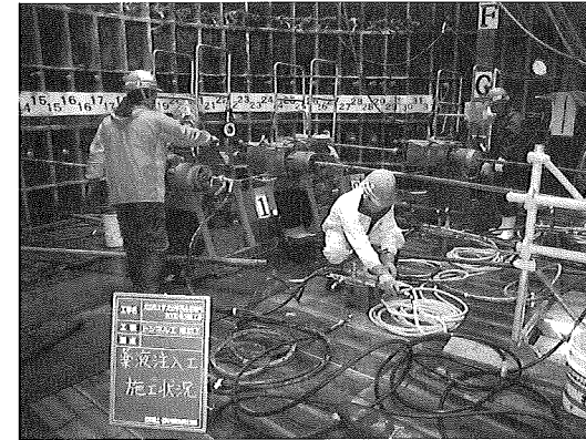
写真-2 低圧浸透注入状況
