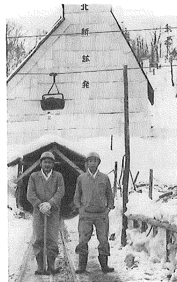
雪囲いした立坑槽。左が筆者
