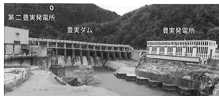
写真-1 豊実ダム、豊実発電所施工前全景
