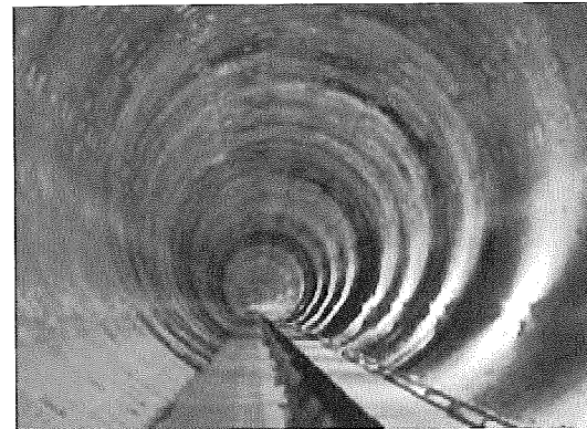
写真-4 大断面トンネルの例
