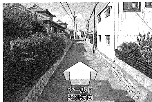
写真-1 残置鋼矢板上の道路・近接家屋の写真 路となり、近隣家屋と非常に近接することになる(写真-1)。
