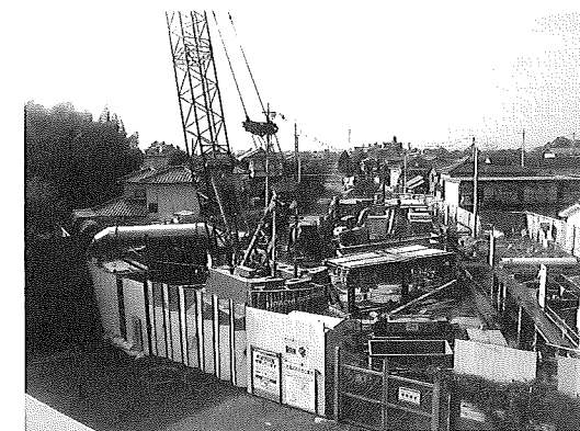
写真-5 ポンプ所屋上から見た現場
