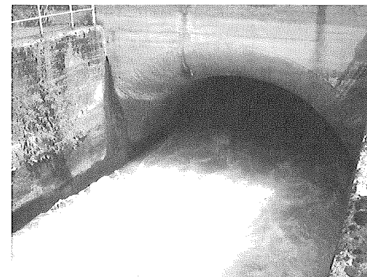
写真-2 水路トンネルの例①
