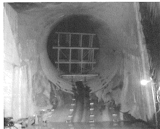
写真-10 セントル解体後の変断面部
