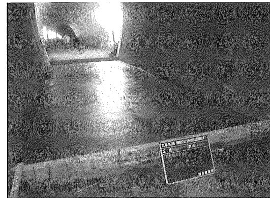
写真-10 路盤ストラットコンクリート
