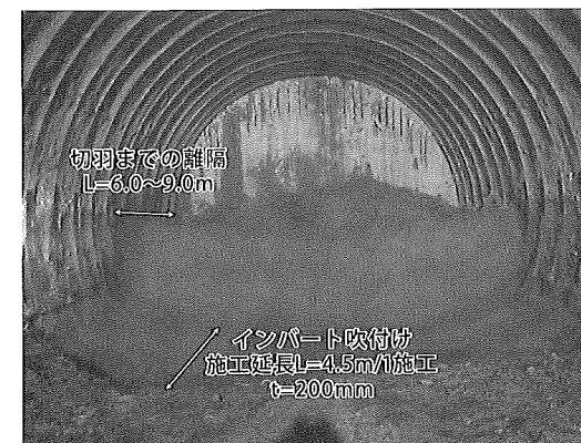
写真-5 インバート吹付けによる早期閉合状況
