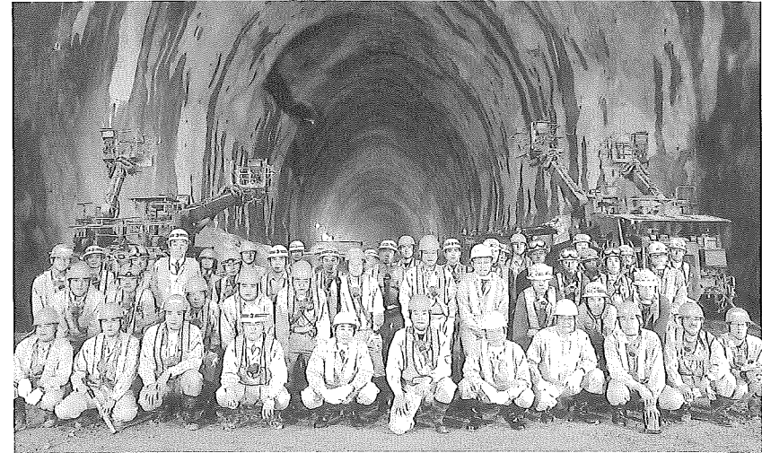
波方ブタン/プロパン貯槽にて
