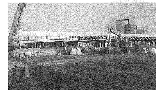
写真-3 工事用専用跨線橋
