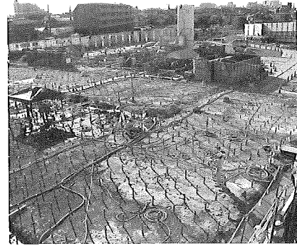
写真-5 地盤改良施工状況
