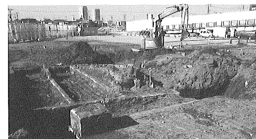
写真-1 支障物状況
