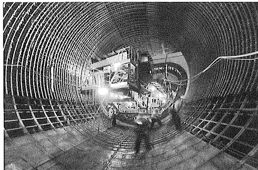
写真-1 二次覆工の施工状況
