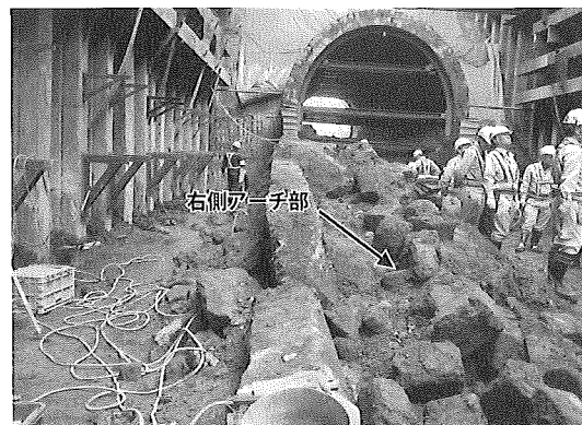
写真-5 B-B断面状況(起点を背に左)
