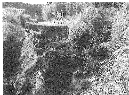
写真-2 トンネル崩落状況(上部)
