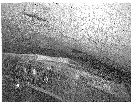
写真-4 展張状況
