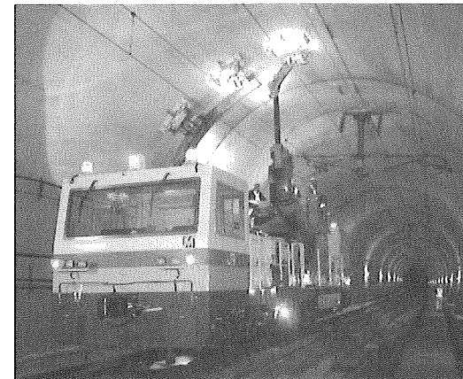
写真-1 新幹線トンネル覆工検査車
