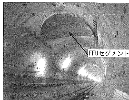
写真は上向きシールド発進部
