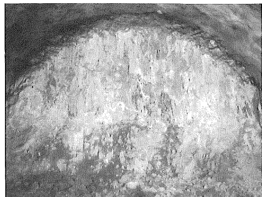
写真-1 切羽地質状況
