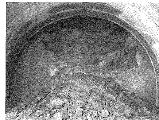
写真-2 曲面切羽鏡面崩落(鏡ボルトなし)
