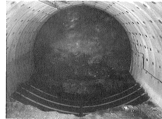
写真は全断面早期閉合状況
