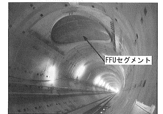
写真-3 上向きシールド発進部
