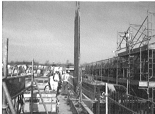
写真-7 側壁鋼製パネル型枠撤去状況
