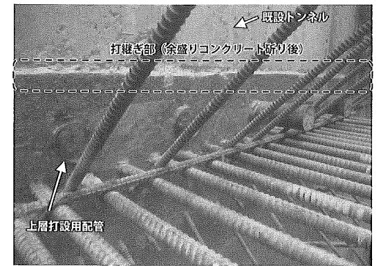
写真-5 既設トンネル境界部の仕上がり状況
