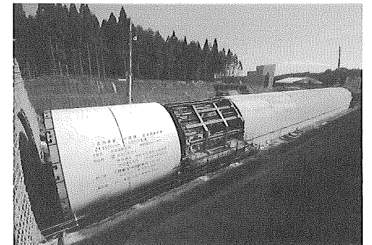
写真-2 津軽蓬田トンネル坑口部
