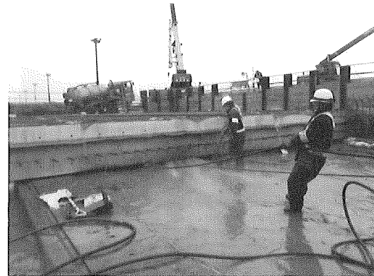
写真-8 頂版砂型枠洗い流し状況
