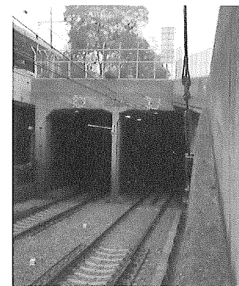
神戸高速鉄道元町北工区の現況
