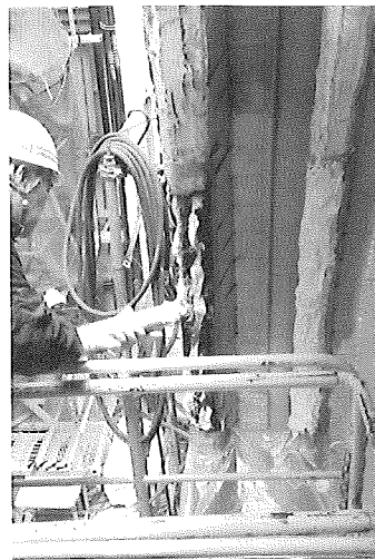
写真-2 シリコンゴム塗布状況
