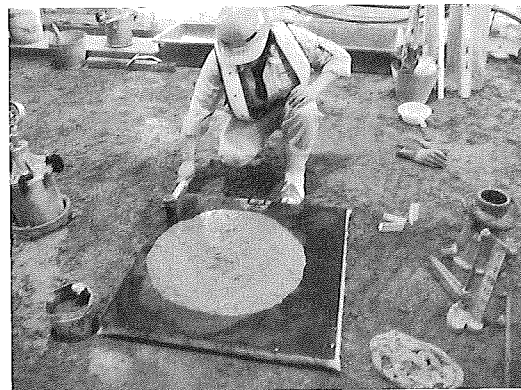
写真-4 日常管理試験(スランプフロー)
