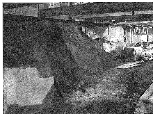
写真-6 小段掘削状況
