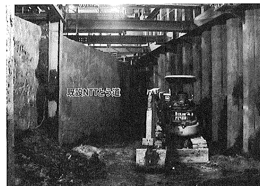
写真-1 既設NTTとう道(掘削時)
