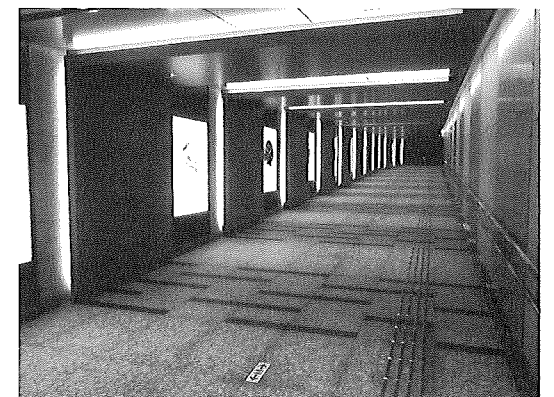
写真-9 地下通路完成状況
