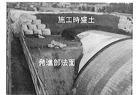
写真-3 地上発進完了
