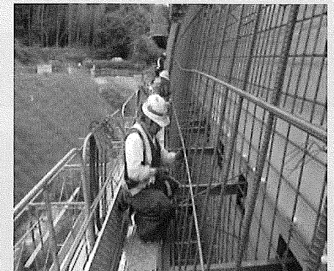
IN側セントル窓から鉄筋工事用足場をスライドし、ケレン・鉄筋組立て工事を完了。 (スライド足場収納式IN側スライドセントル:特許品)
