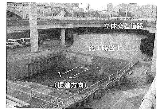
写真-7 地上到達位置盛土
