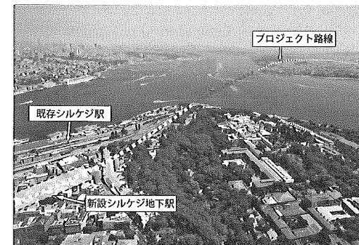
写真はボスボラス海峡横断鉄道トンネル路線
