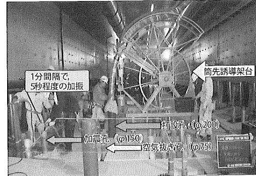
写真-8 下床版打設状況
