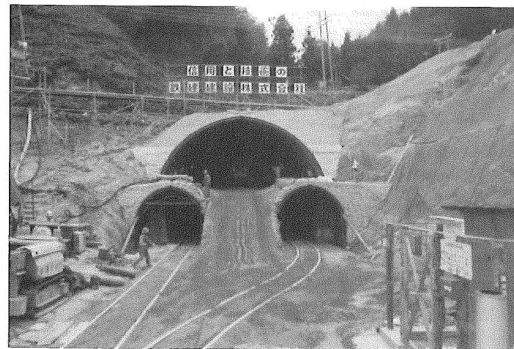
米山トンネル坑口
