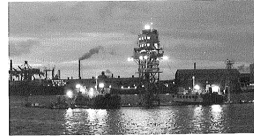
写真-9 沈埋函曳航状況(夜間)
