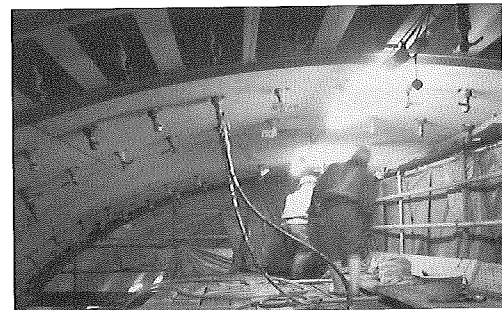
写真-1 低圧浸透薬液注入工法の施工状況
