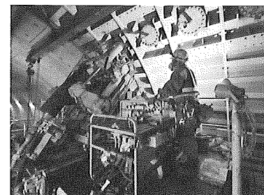
写真-2 曲線パイプルーフ施工機械
