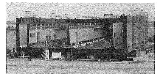
写真-3 鋼殻製作状況(陸上ヤード)
