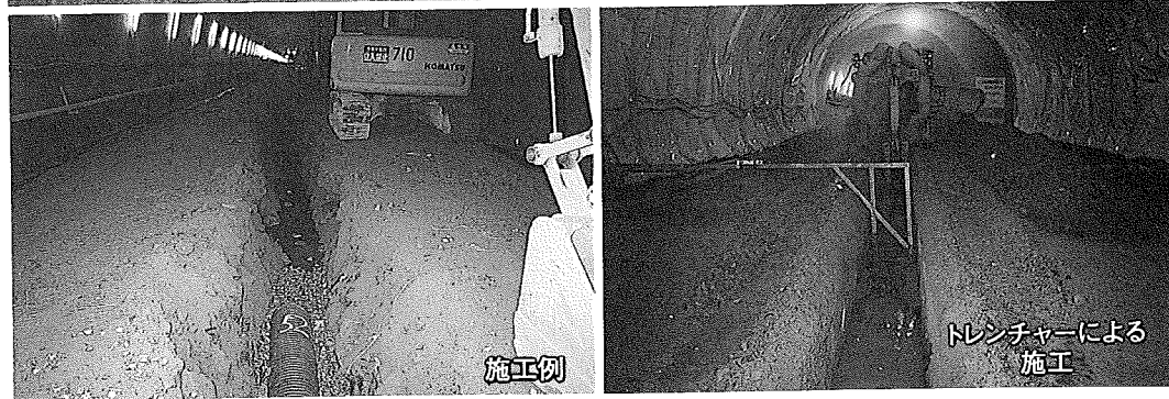
トンネル中央排水路 掘削状況
