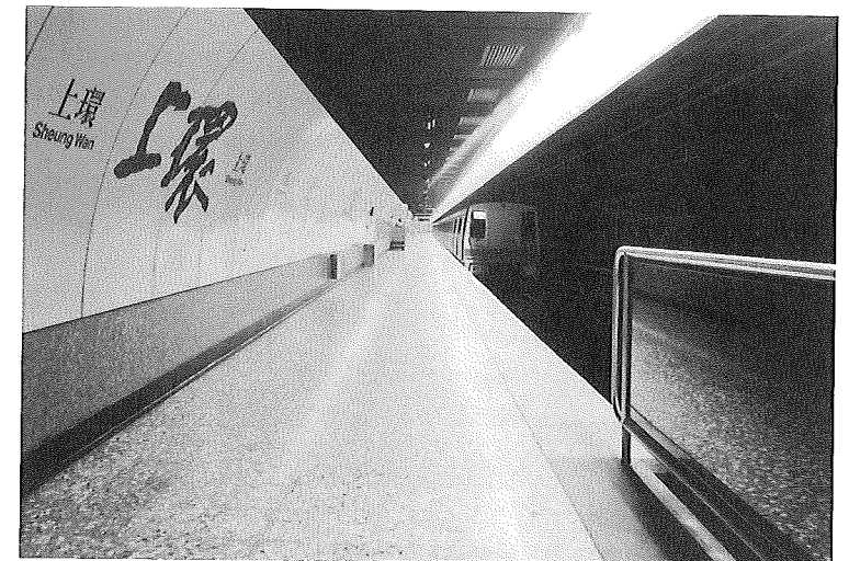
香港地下鉄402工区駅部完成状況
