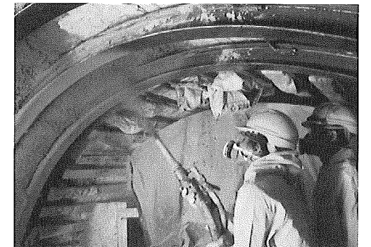
写真-9 鋼リング支保工設置、ファイバーモルタル吹付け状況
