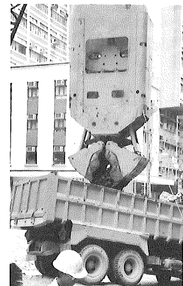
香港地下鉄402工区開削部で用いた連発バケット
