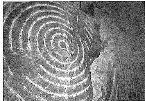
写真-11 山はね状況(カッタヘッド前面)
