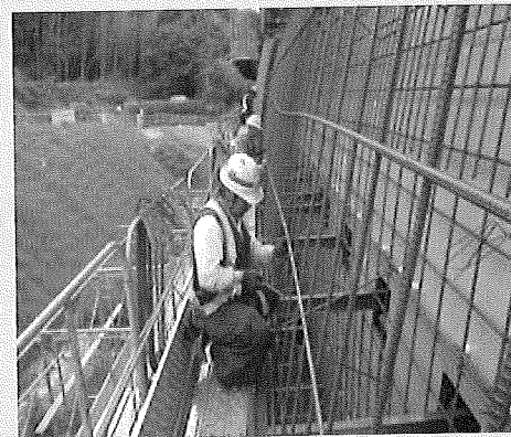
IN側セントル窓から鉄筋工専用足場をスライドし、ケレン・鉄筋組立て工事を完了。 (スライド足場収納式IN側スライドセントル:特許品)
