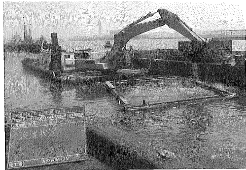
写真-3 一次浚渫状況
