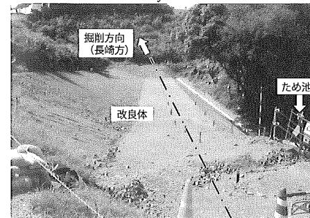
写真は地山改良工の施工完了状況
