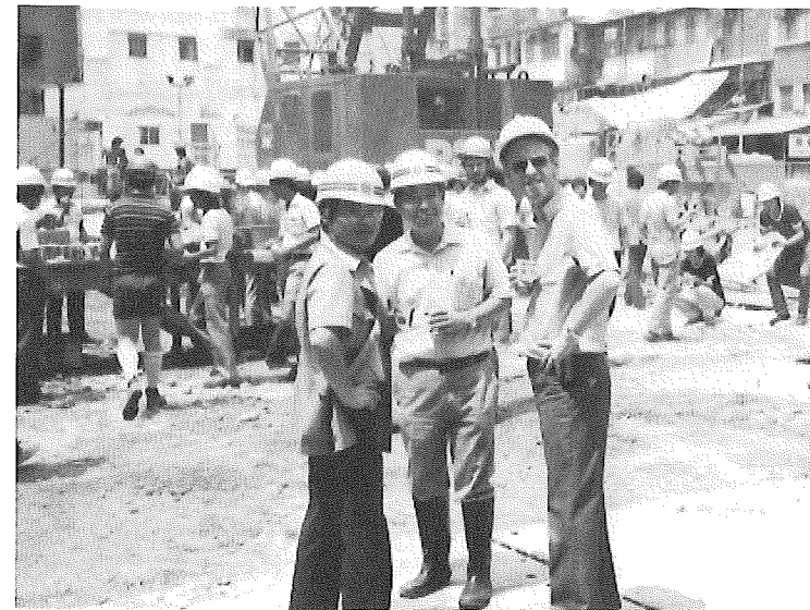
香港地下鉄402工区でのシールド発進開削部着工セレモニー状況(中央が筆者、左が市川氏、右がラーキン氏)
