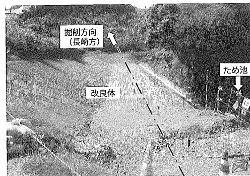
写真-2 地山改良工の施工完了状況
