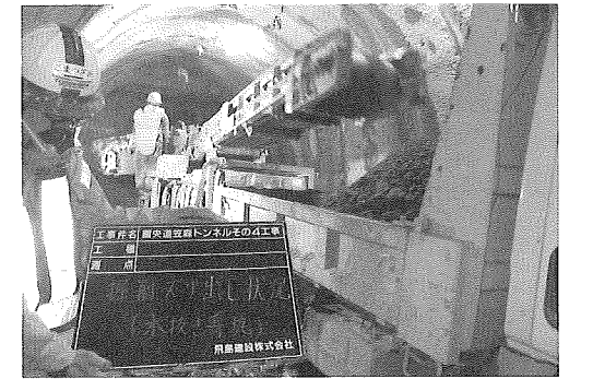
写真-3 水抜き導坑掘削状況
