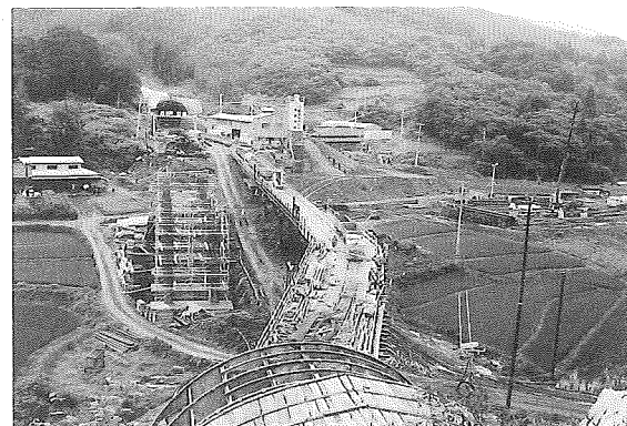
志賀トンネル南坑口(中井トンネル北坑口より望む)
