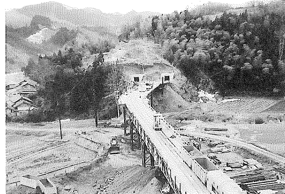
中井トンネル北坑口(志賀トンネル南坑口より望む)
