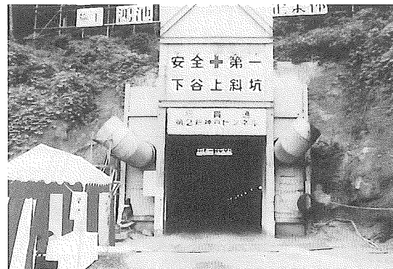
下谷上斜坑入口(第2新神戸トンネル)
