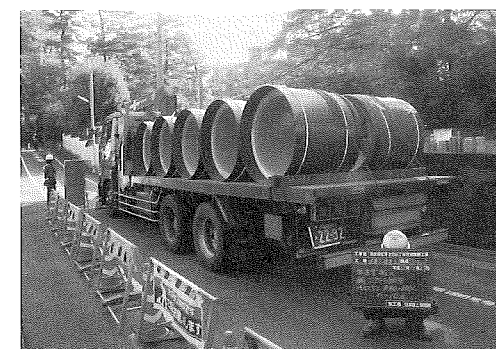
写真-5 鋼コンクリート合成管(φ900mm, L=800mm, 3種管)
