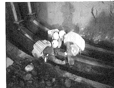
写真-2 鋼インバート支保工の施工
