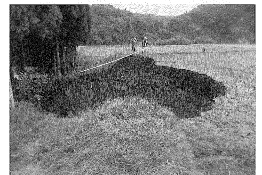
写真-2 土砂流入状況(上)と地表面陥没箇所全景(下)
