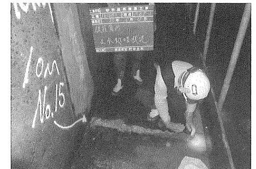
写真-10 止水処理状況
