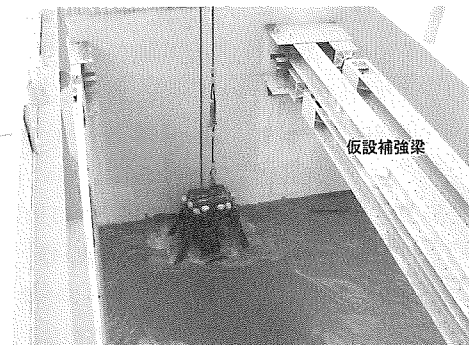
写真-2 到達立坑掘削状況
