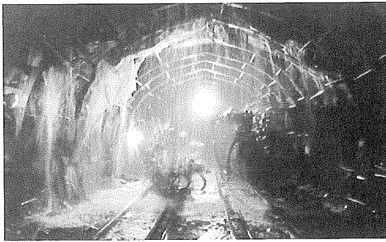
補助坑湧水状況
