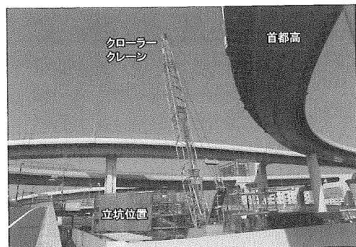
写真-1 発進立坑施工状況
