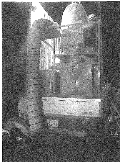
写真-20 集塵機設置状況
