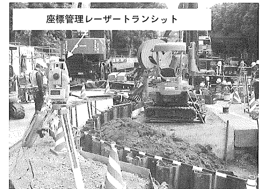
写真-2 測量管理状況
