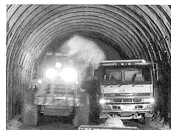
写真-4 側壁導坑上半掘削
