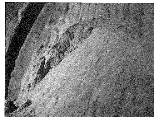
写真-2 切羽崩壊(1)
