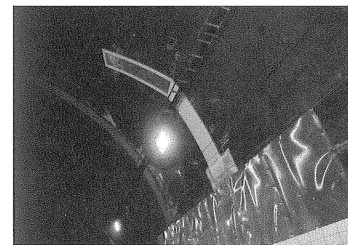
写真-3 透明導水樋
