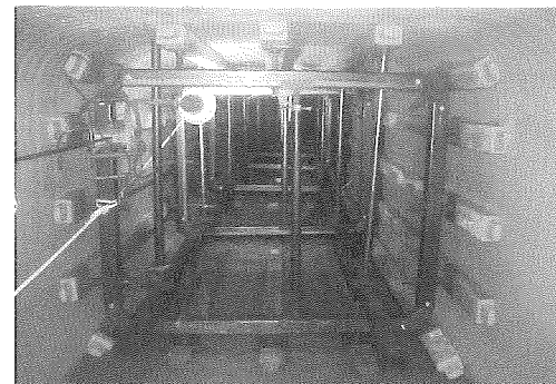
写真-5 支保工組立て完了(管内)
