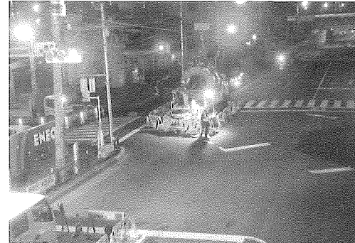
写真-4 製管状況(地上)
