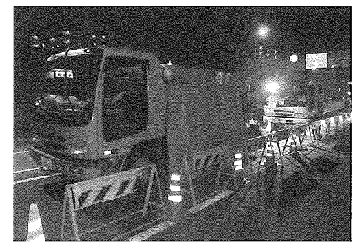
写真-19 防音シート設置状況
