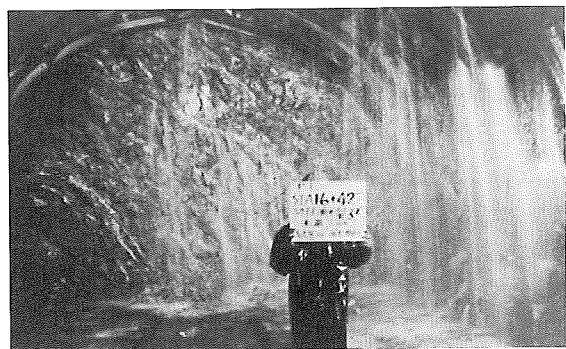
補助坑湧水状況
