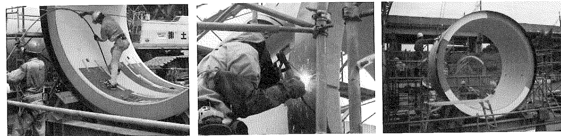
④鋼製カラー部溶接
