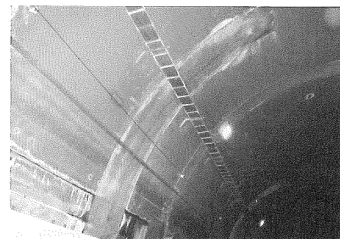
写真-10 導水シートによる湧水対策
