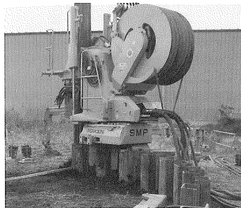
写真-1 鋼矢板の円形打設
