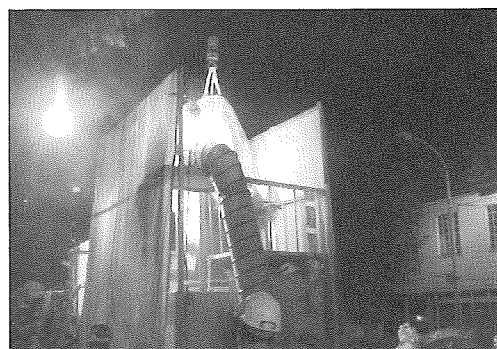
写真-21 飛散防止シート
