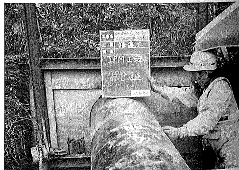
写真-4 φ600鋼管推進
