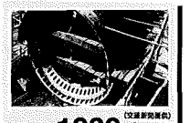
1939 (日本最初の本格的シールド) 関門トンネル工事で活躍
