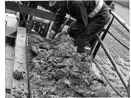
写真-5 既設管破砕片と土砂の排出
