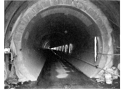
写真-10 縫返し後の円形断面構造
