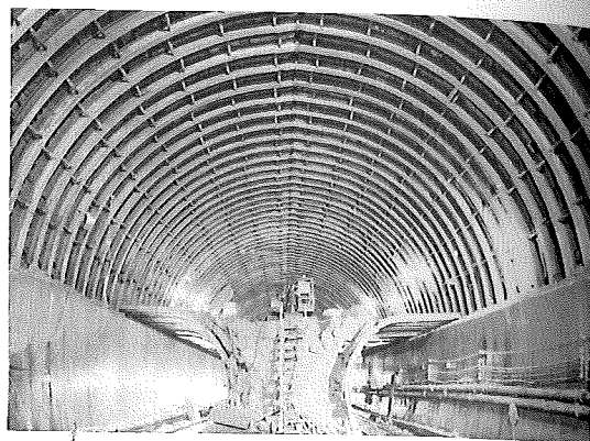
本坑全体写真(榛名山ずい道)
