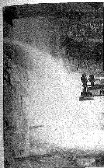
本坑切羽の湧水状況(新清水ずい道)
