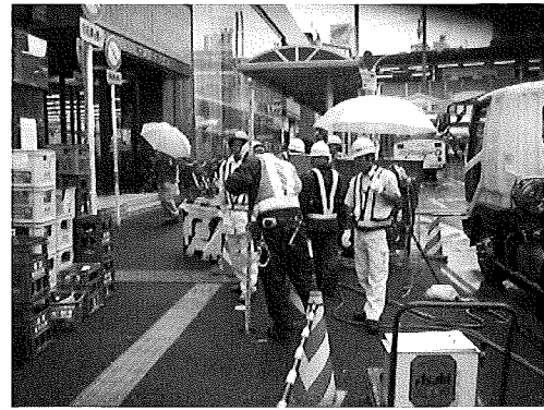
写真-7 ガス管沈下測定
