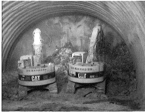
写真-4 掘削状況(2編成)
