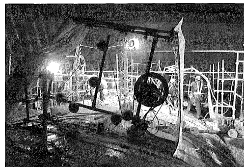
写真-8 覆工輪切りワイヤーソー切断
