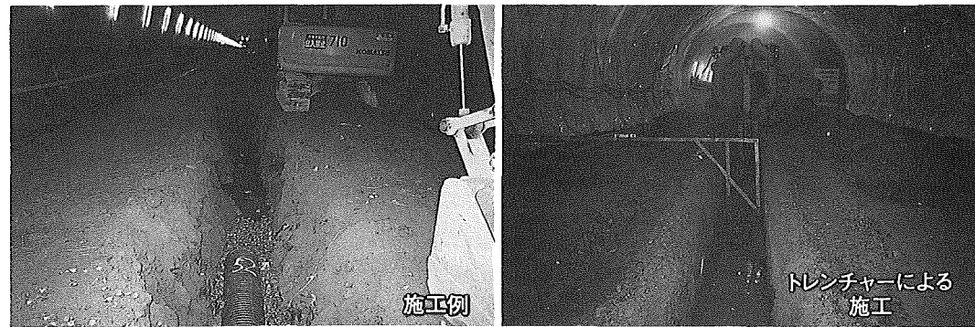
トンネル中央排水路掘削状況
