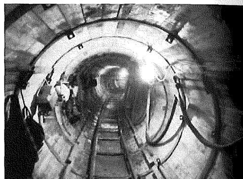
写真-1 rib and lagging 構造 ( http://www.tunnelcanada.ca/PDFs/newsletter/TAC_2009_P3-1.pdf より)
